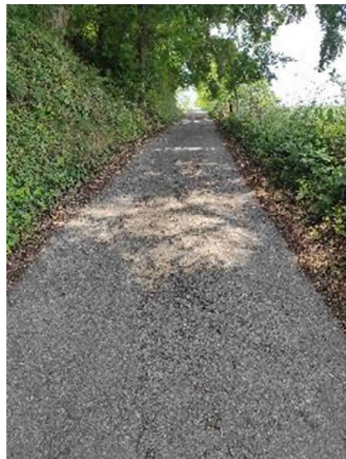
Bild 12: Verlauf des Hohbergweges in westliche Richtung
