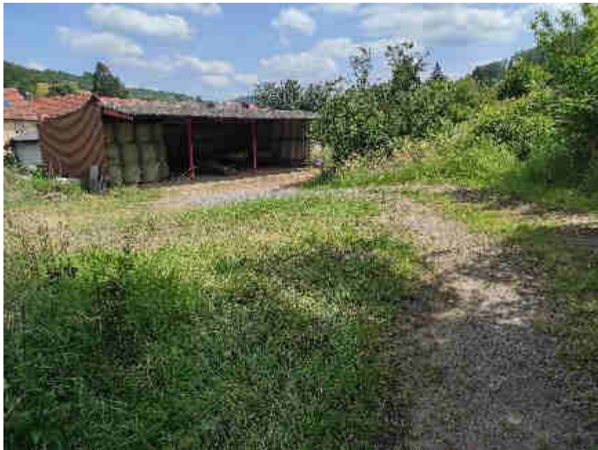
Bild 7: Blick vom Eingang am Mühlbergweg mit Abfahrt zur Maschinenhalle
