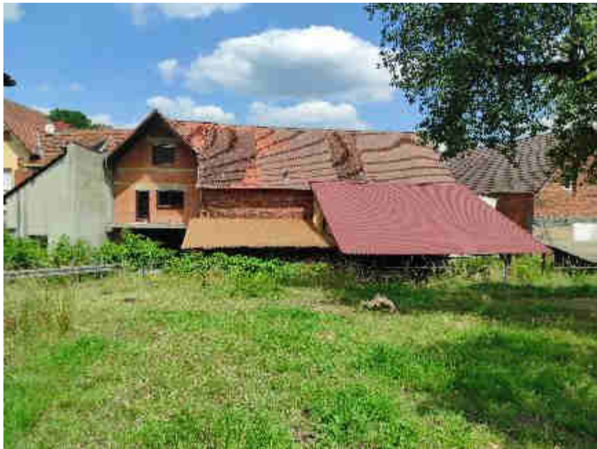
Bild 5: Blick auf die Bebauung Nibelungenstraße 69
