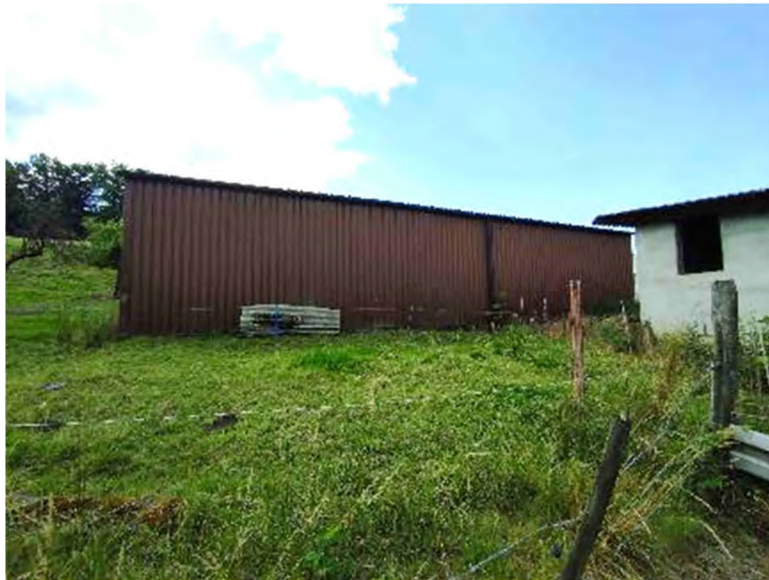
Bild 1: Nordansicht der Maschinenhalle
