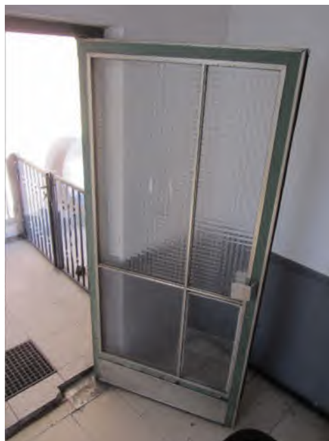
Bild 26: Zugang außenliegendes Treppenhaus zum Laubengang
