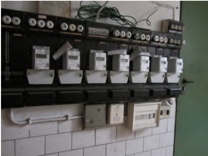
Bild 45: Elektroähler im Keller
