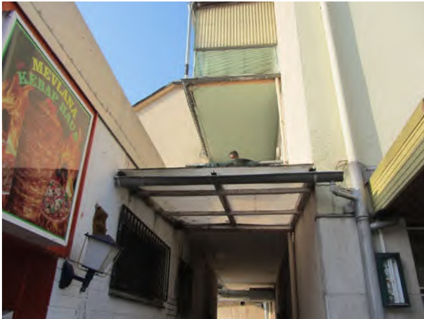
Bild 47: Durchgang zwischen Kebab-Restaurant und Gebäude
