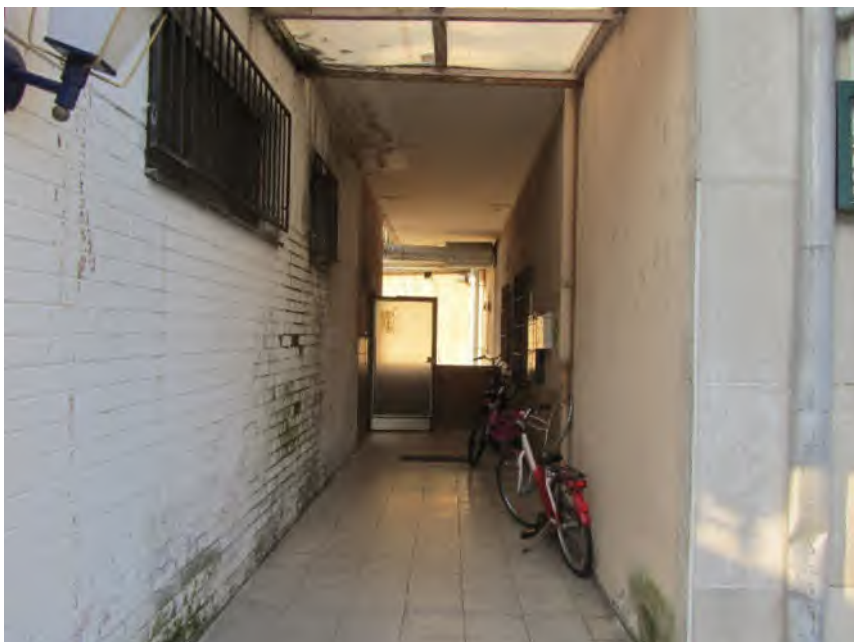
Bild 20: Durchgang zum außenliegenden Treppenhaus
