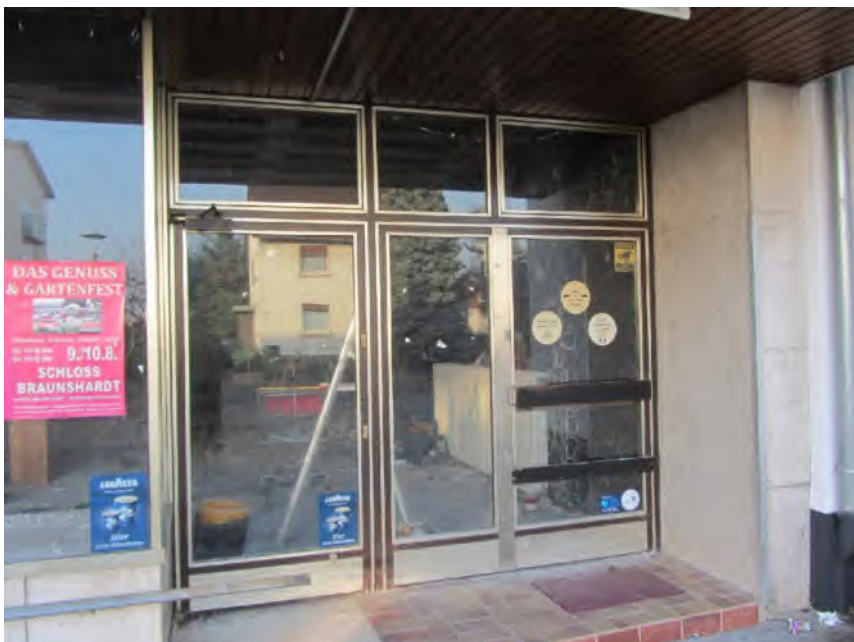
Bild 8: Eingang Gewerbeeinheit 03- Sanierungsfläche
