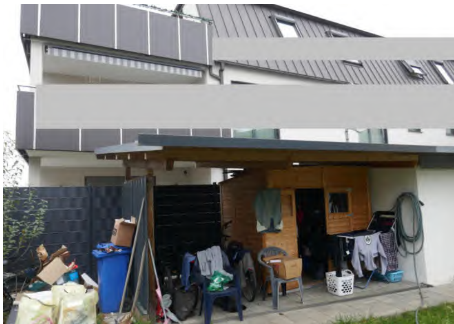
Ansicht Vordach und Holzschuppen und dem Nachbarwohnhaus (MFH) im Hintergrund
