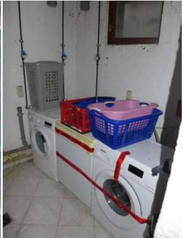
21 b Waschküche Wohnhaus B
