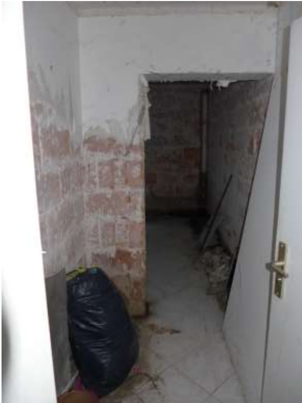
23 a Zugang Hausmeisterraum Wohnhaus B
