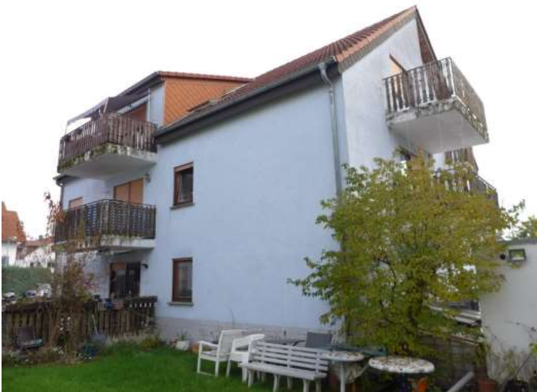
4 Wohnhaus A (Westansicht)
