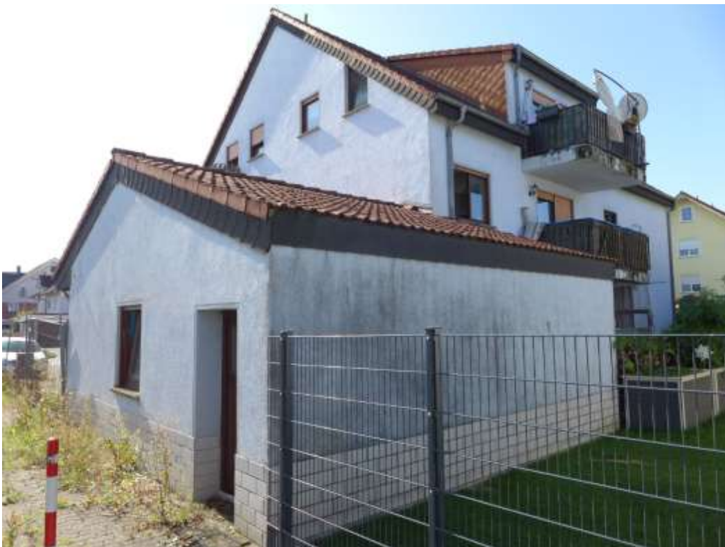
18 Garagenrückseite, Rückseite Wohnhaus B
