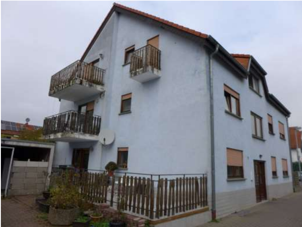
3 Wohnhaus A (Südansicht)
