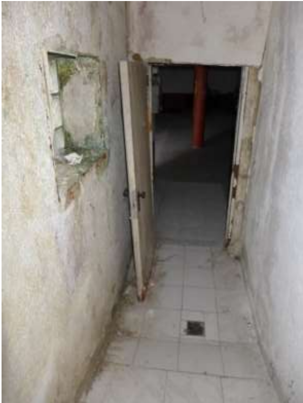
25 a Zugang zur Tiefgarage Wohnhaus B
