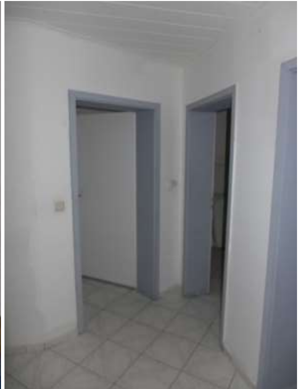
27 b Zustand Flur Wohnung Nr. 12
