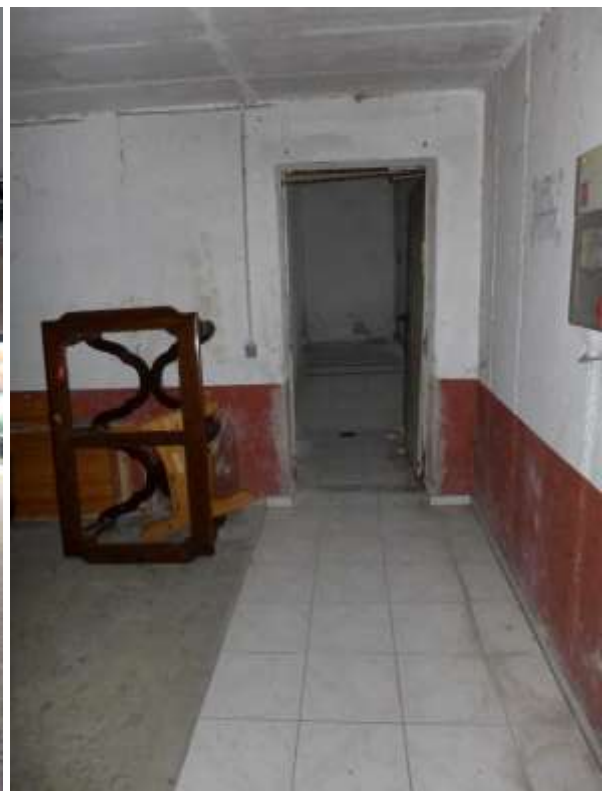
10 b Beispiel Zustand Tiefgarage
