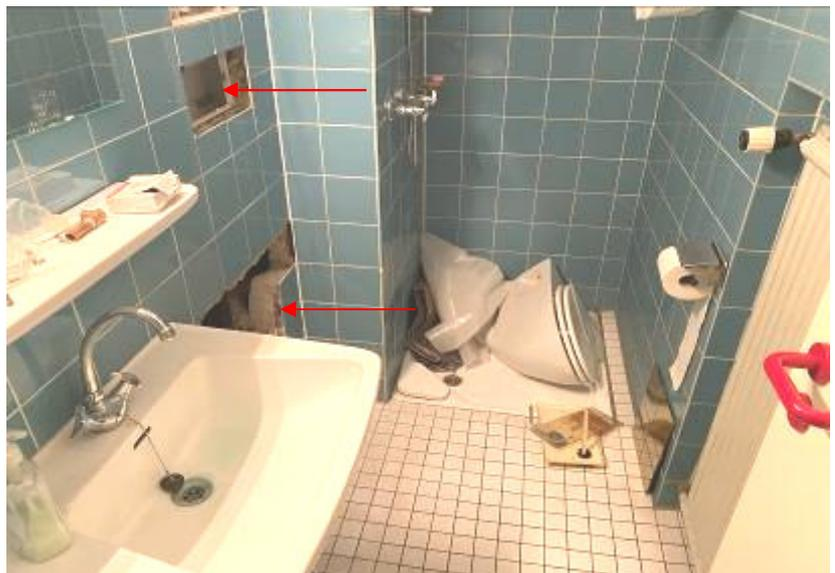
**Abb. 10:** Foto des SV; z.T. Fliesen schadhaf/fehlend
