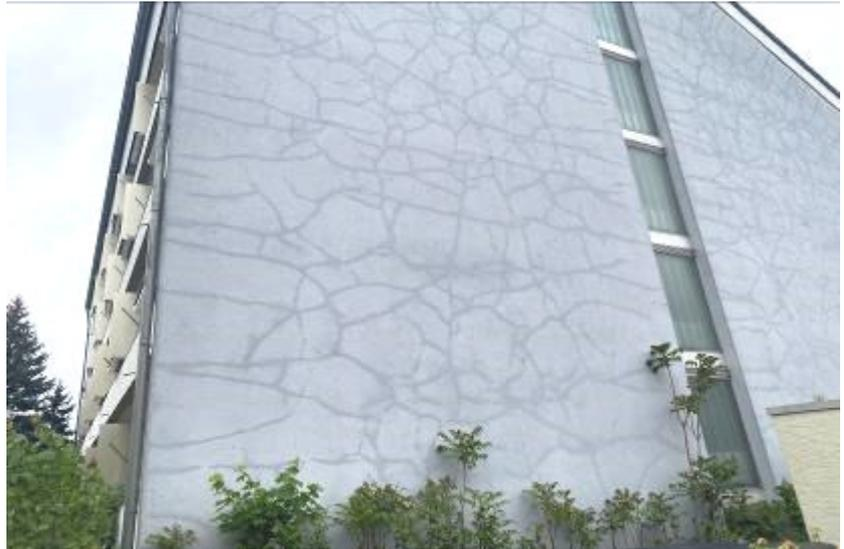
**Abb. 6:** Foto des SV; z.T. Fassade schadhaft (Risse WDVS Südgiebel)
