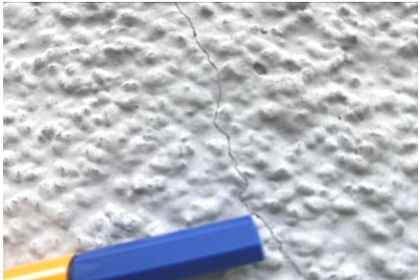
**Abb. 7:** Foto des SV; z.T. Fassade schadhaft (Risse WDVS Südgiebel), Detail
