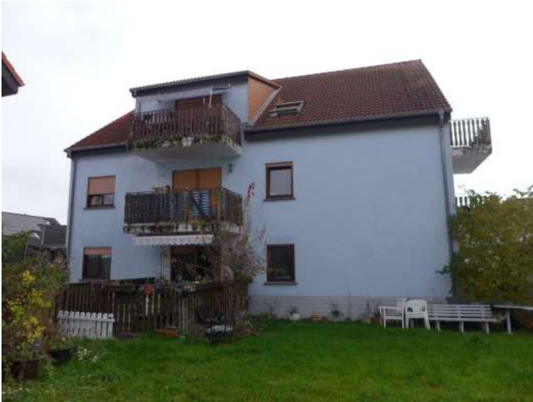
5 Wohnhaus A (Nordwestansicht)
