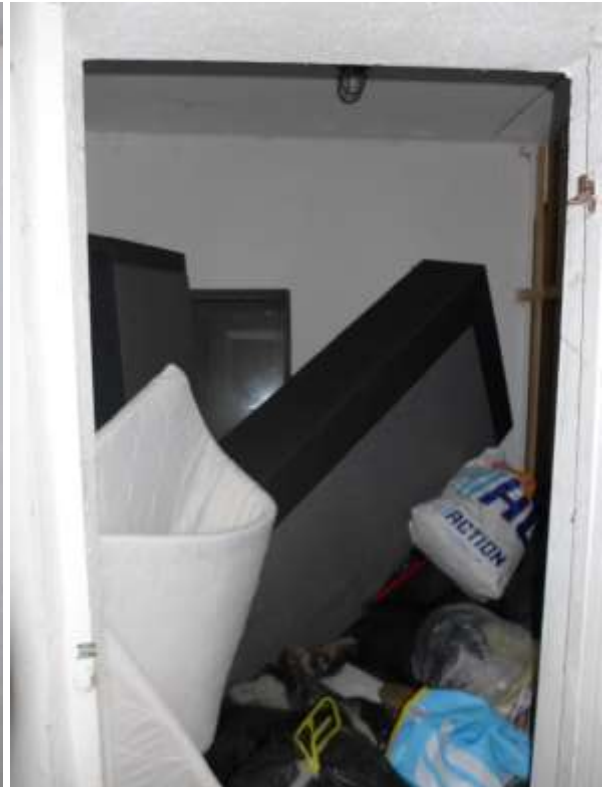
21 b Zustand Raum Wohnhaus A
