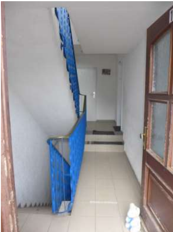
14 Treppenhaus Wohnhaus B
