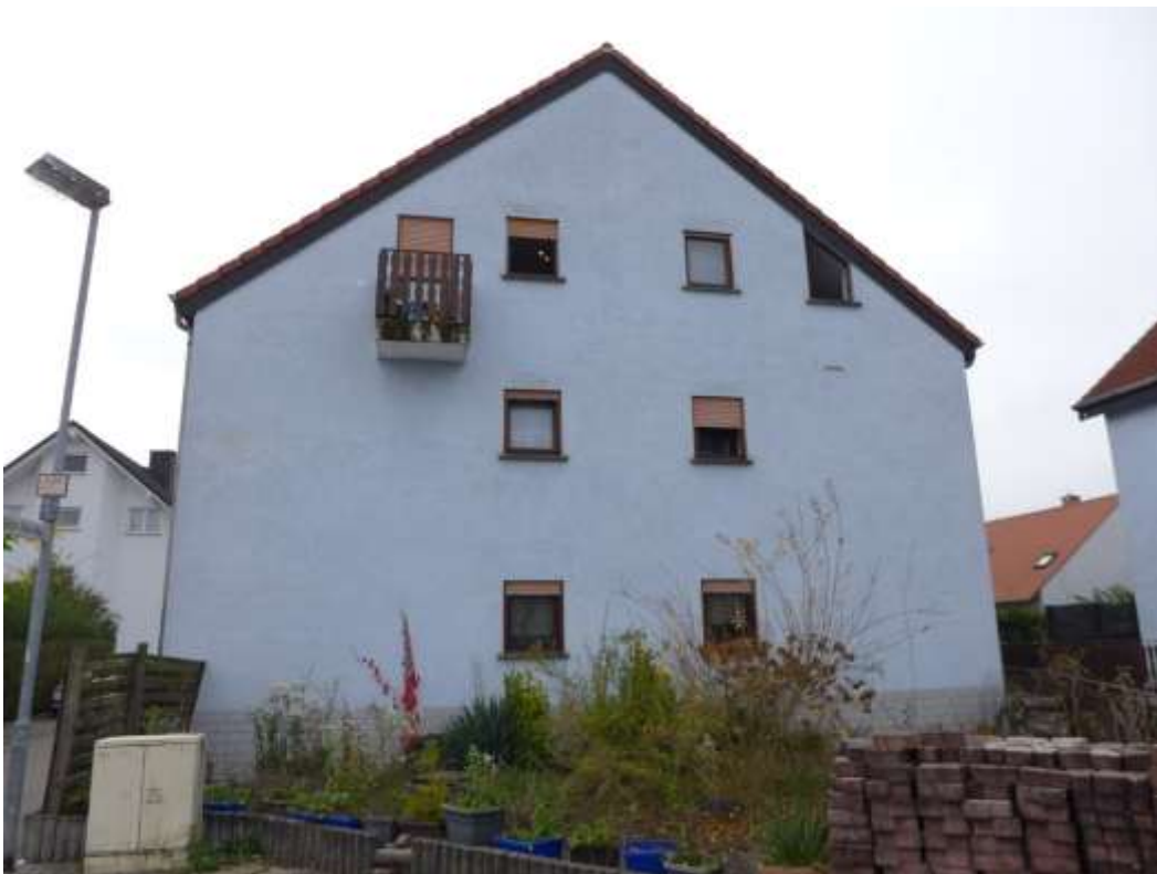
6 Wohnhaus A (Nordostansicht)
