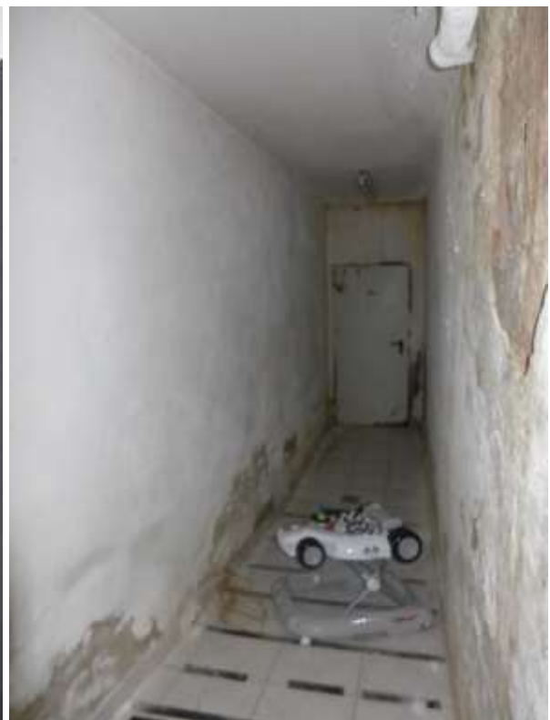
22 b Zustand Kellerflur zur TG Wohnhaus A
