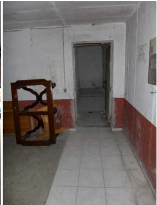
10 b Beispiel Zustand Tiefgarage
