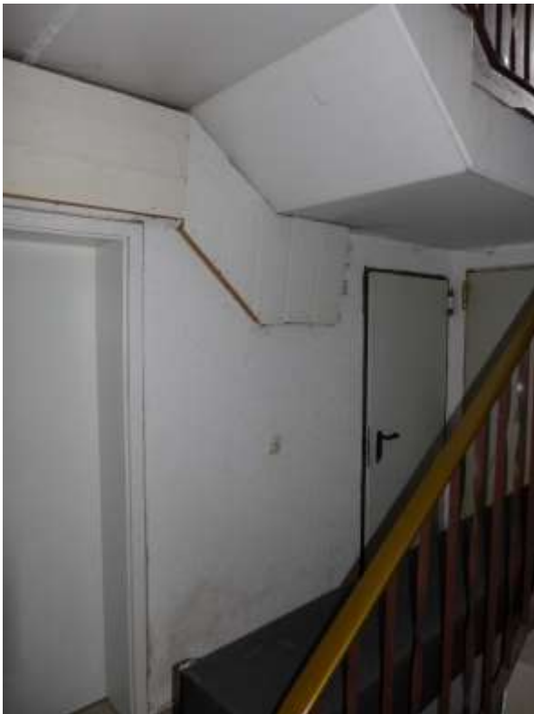
20 a Kellerflur Wohnhaus A
