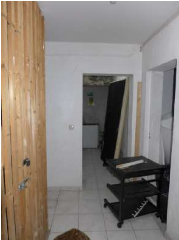
21 a Zustand Kellerflur Wohnhaus A
