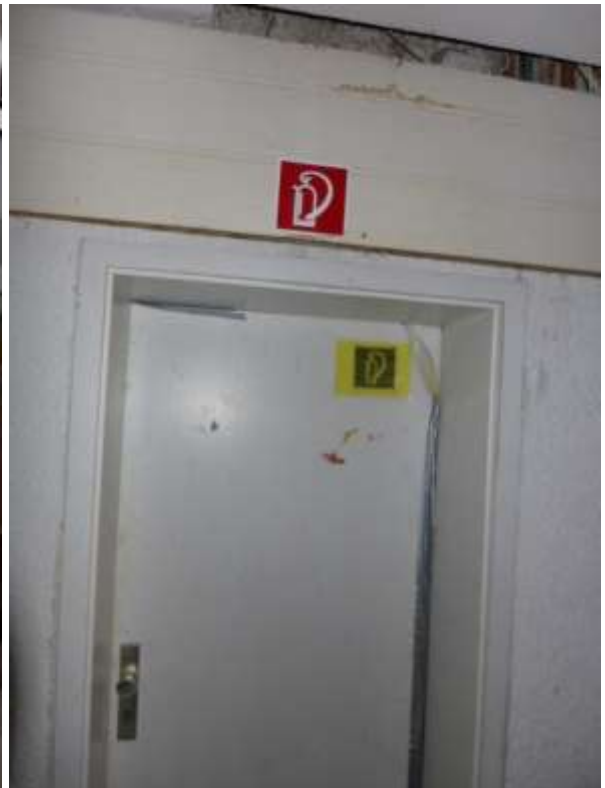
20 b Zustand Kellerflur Wohnhaus A
