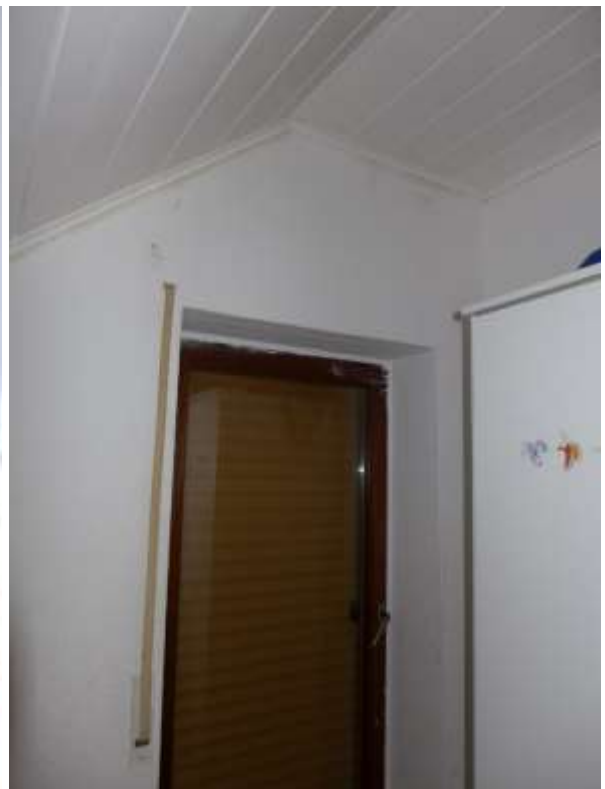
40 b Zustand Zimmer Whg. Nr. 8
