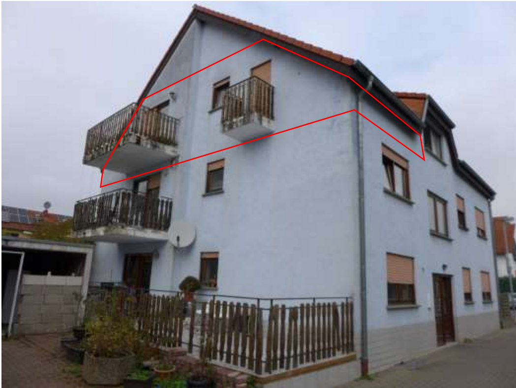
3 Wohnhaus A (Südansicht), Bewertungsobjekt Nr. 8 markiert
