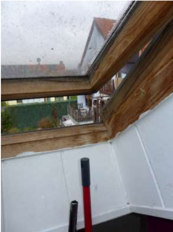
39 a Zustand Dachflächenfenster Whg. Nr. 8
