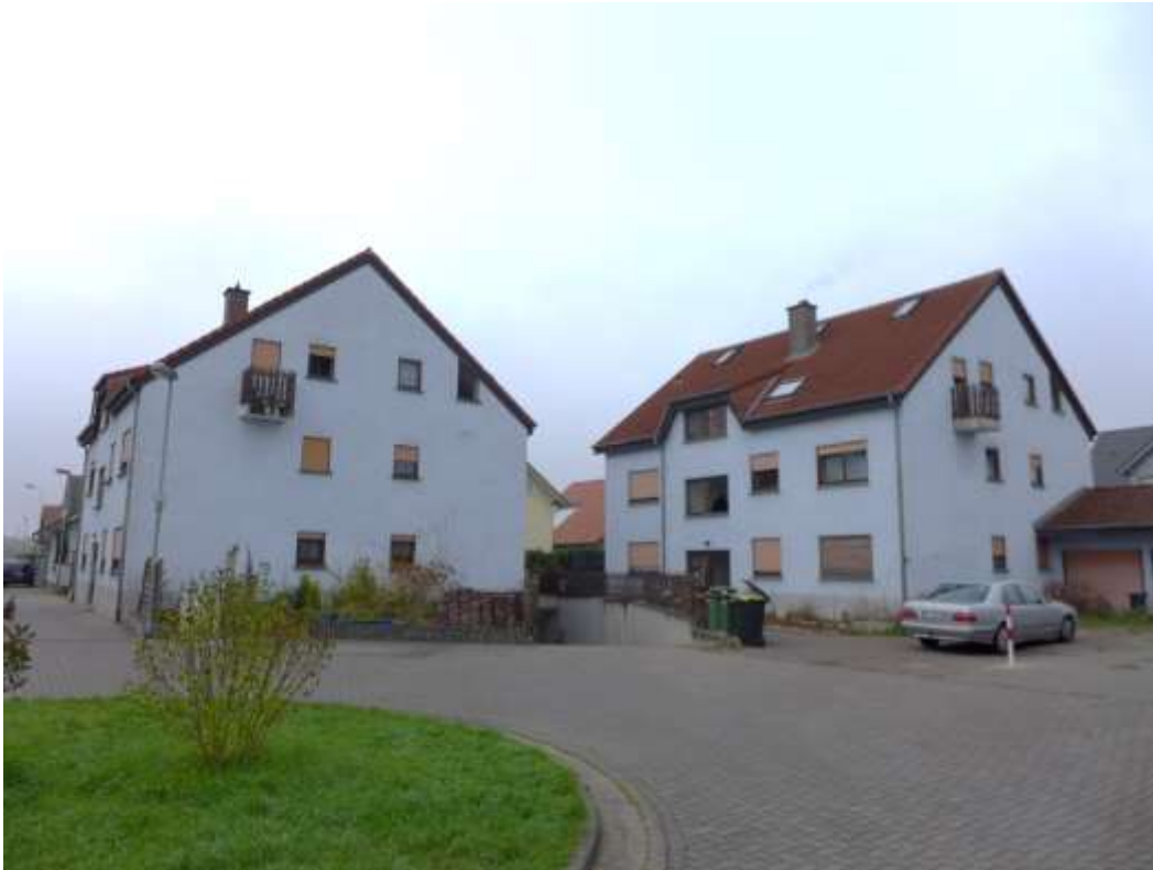
1 Gesamtansicht, Lage in der Straße (Ostansicht)
