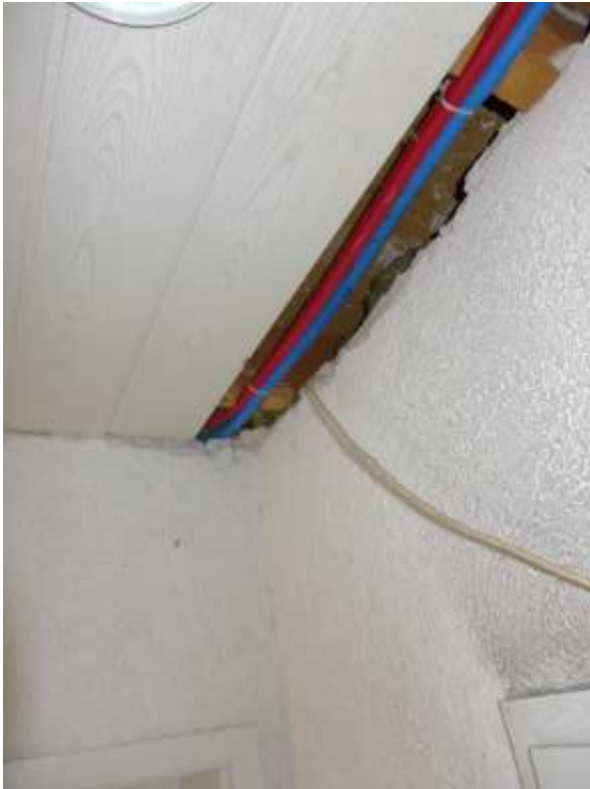
29 a Deckenöffnungen Wohnhaus A
