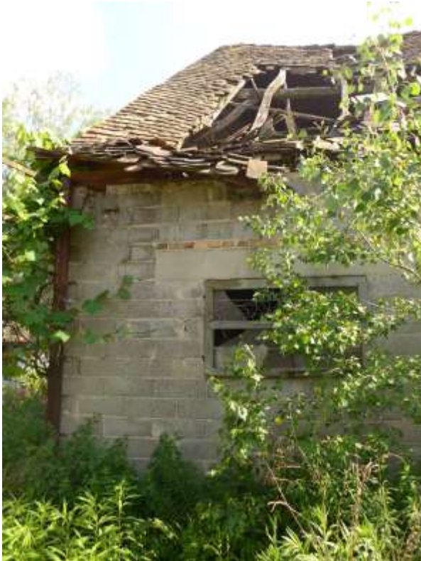
23 a + b Gartenansicht Scheunenanbau (Gebäude 8), defekter Dachstuhl
