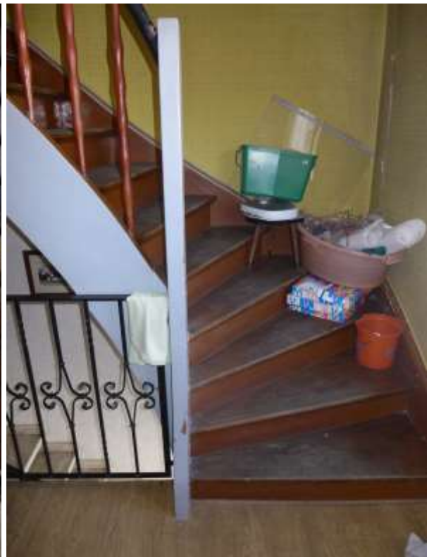
36 b Treppe Altbau (OG zum DG)
