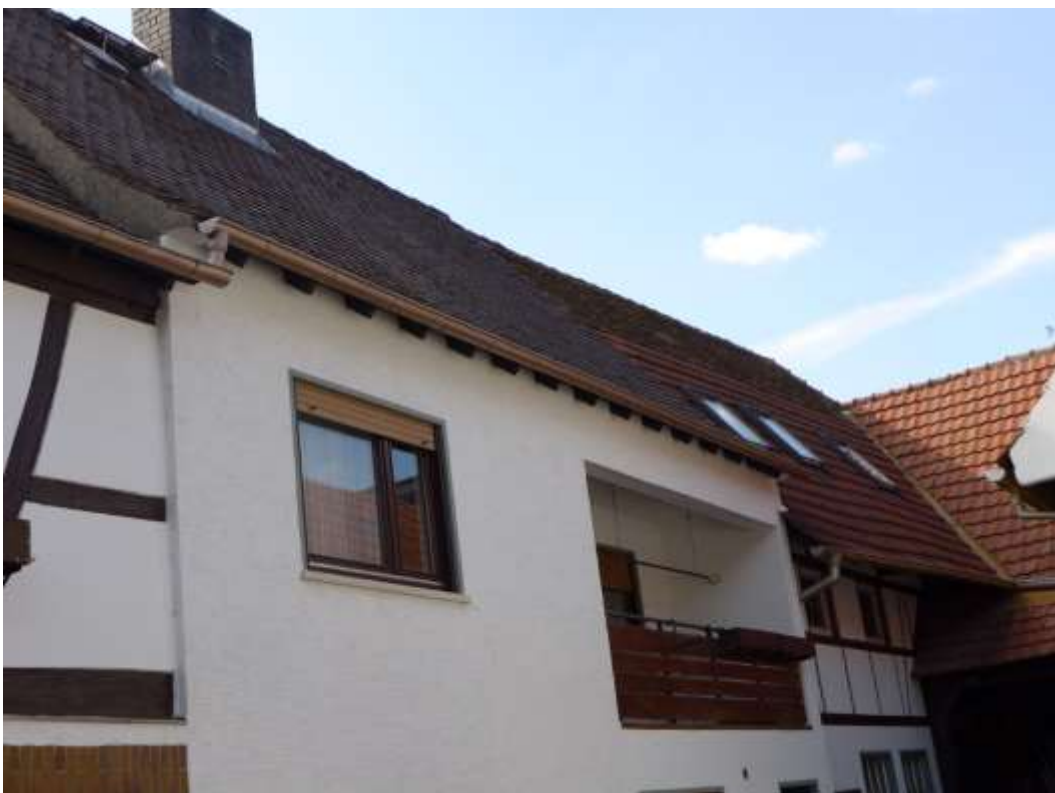
6 Fassade und Dach Neubau
