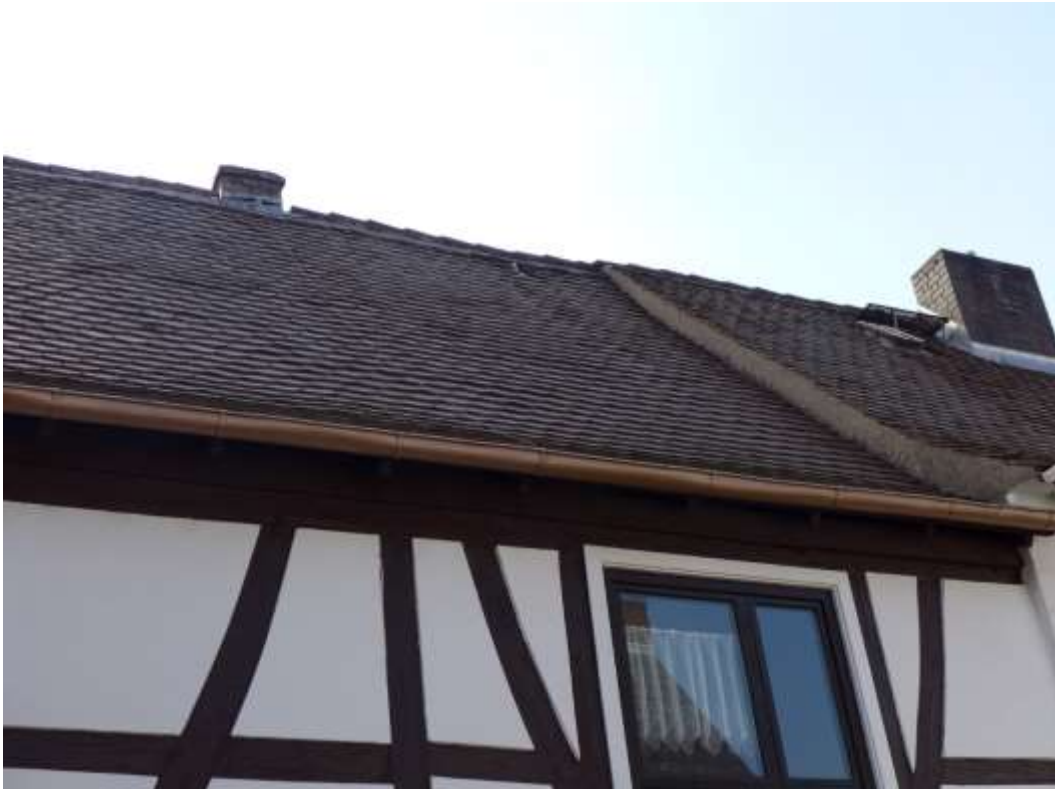
5 Dacheindeckung und Fassade Altbau
