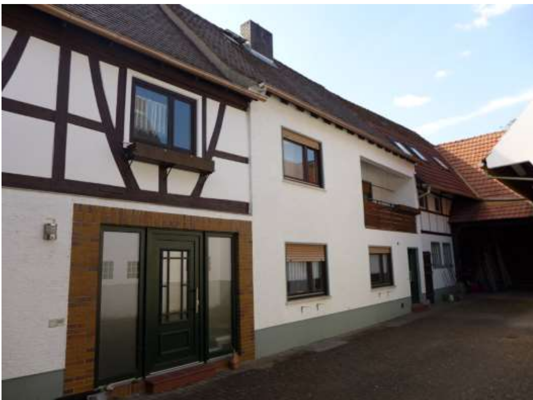
4 Hofansicht Wohnhaus (Gebäudeteile 1 (Altbau links) + 2 (Neubau))
