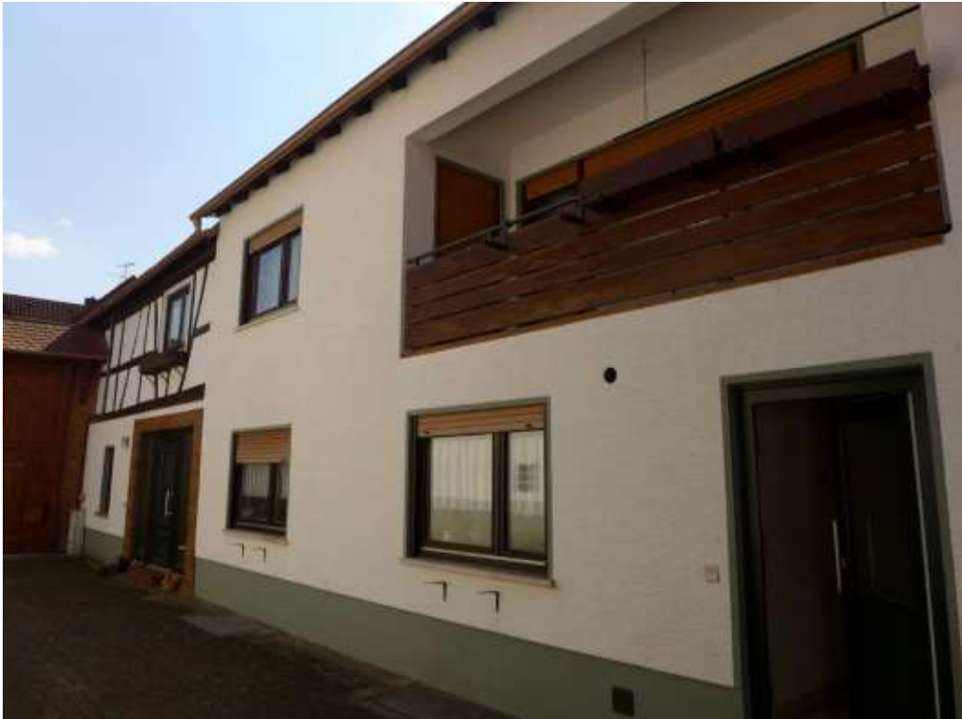
7 Hofansicht Wohnhaus (Neubau (Gebäude 2) rechts, Altbau (Gebäude 1) links)
