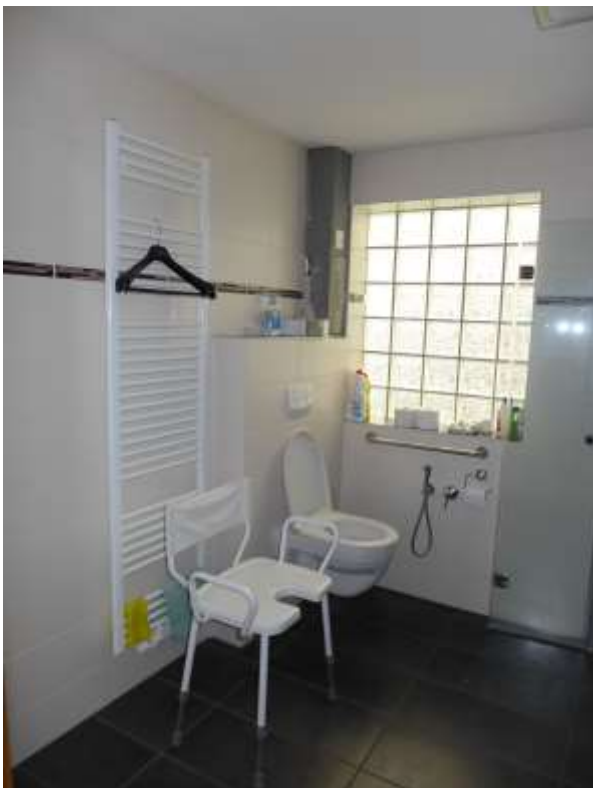
32 a erneuertes Duschbad Erdgeschoss
