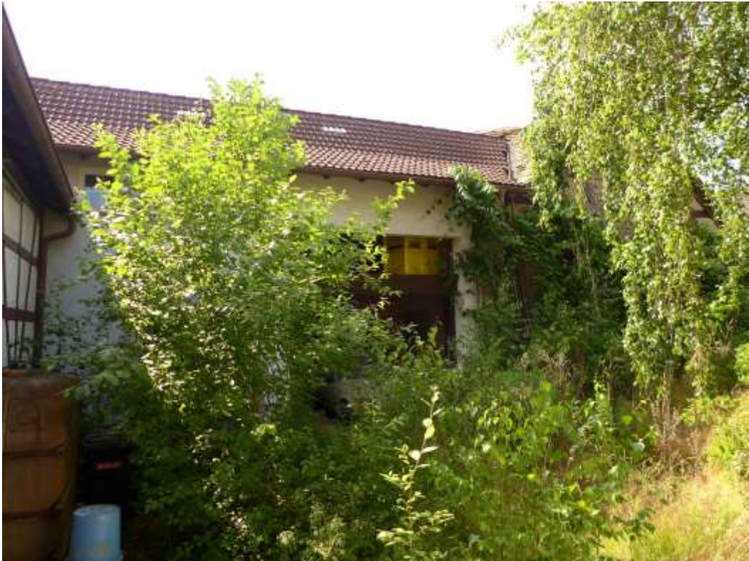
21 Gartenansicht Maschinenhalle (Gebäude 7)
