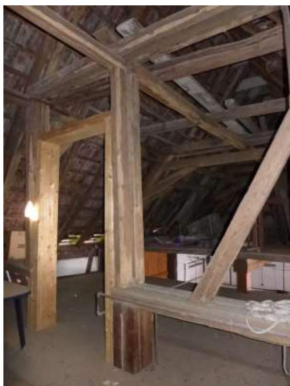
12 Innenansicht Obergeschoss Scheune (Gebäude 4)
