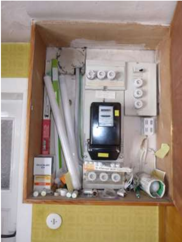
33 a Elektroinstallation Altbau (Gebäude 1)
