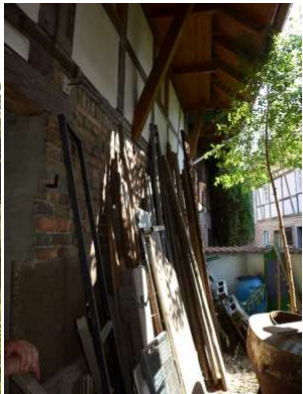
24 b Rückansicht Gebäude 7
