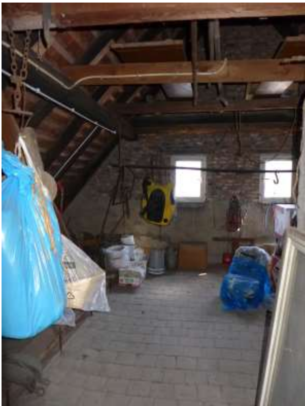
34 Dachboden Alt- und Neubau
