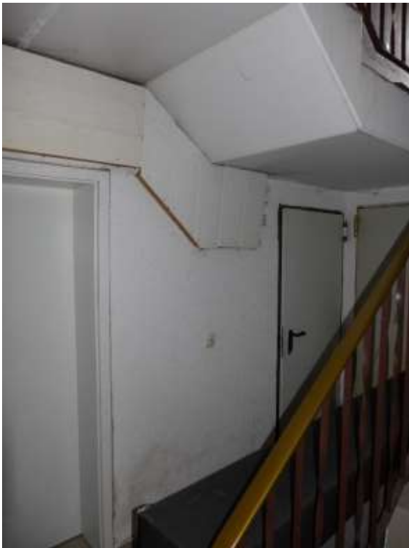
20 a Kellerflur Wohnhaus A
