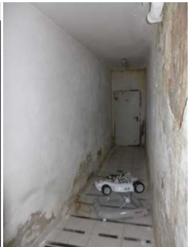
22 b Zustand Kellerflur zur TG Wohnhaus A
