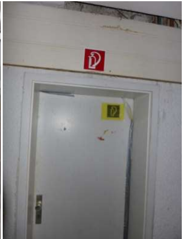
20 b Zustand Kellerflur Wohnhaus A
