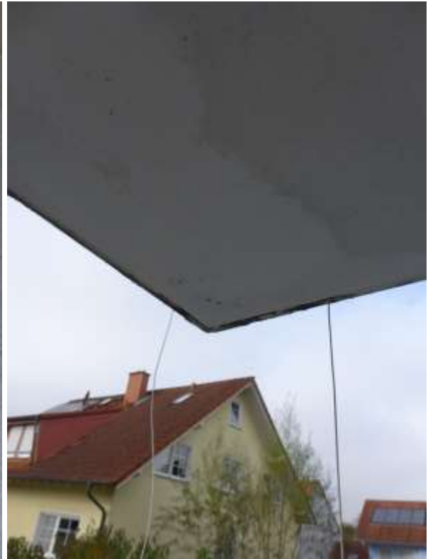
33 a Schmutzläufer Bereich Balkon Whg. Nr. 6 33 b Balkonuntersicht Whg. Nr. 6
