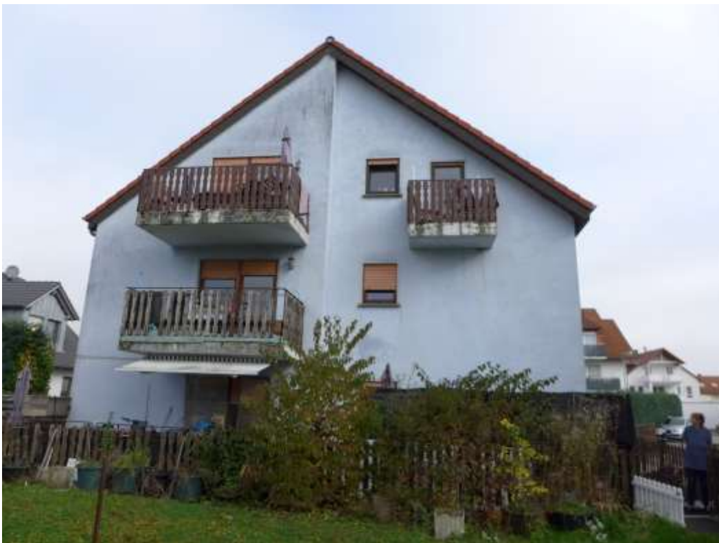
12 Wohnhaus B (Südwestansicht)
