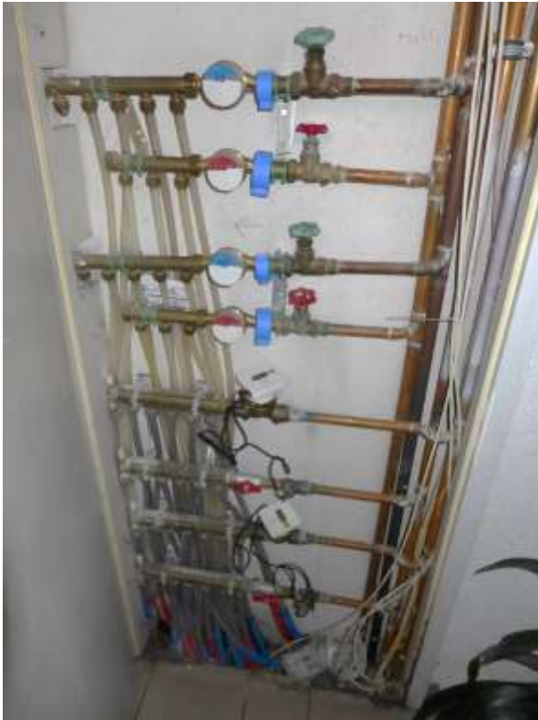
27 a Zustand Verteilung Wohnhaus A
