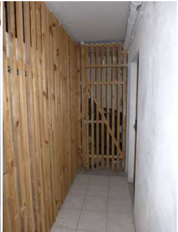
24 b Abstellkeller und Kellerflur Wohnhaus A
