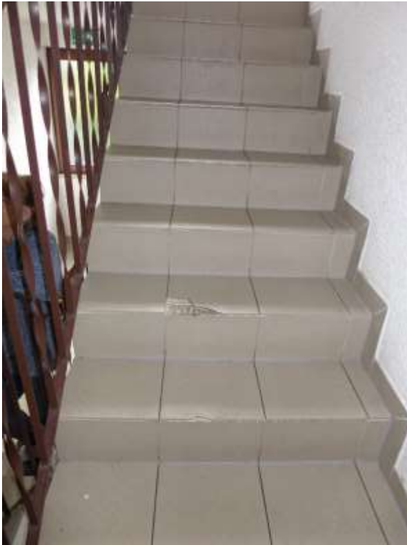
19 a Treppenhaus Wohnhaus A
