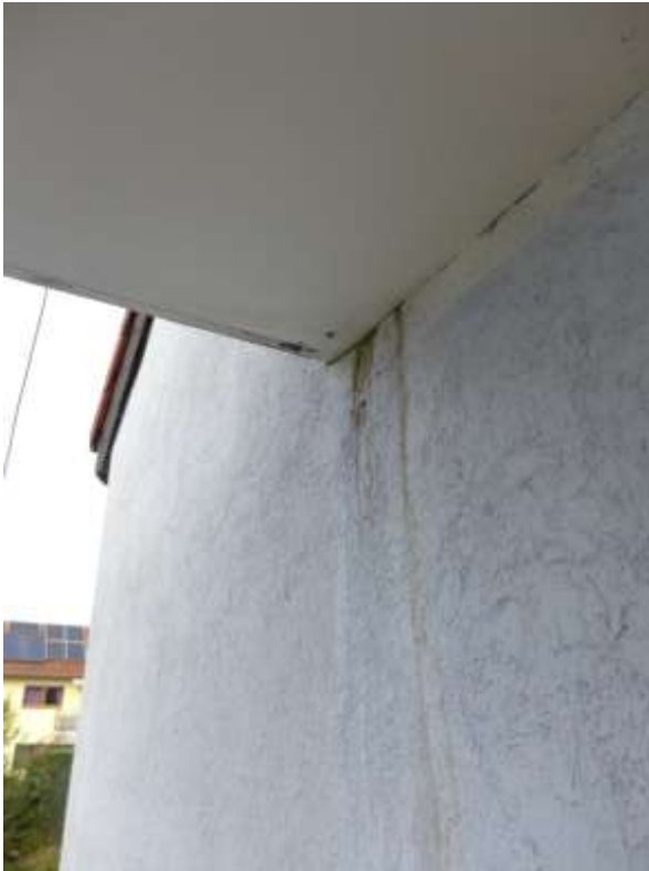
33 a Schmutzläufer Bereich Balkon Whg. Nr. 6 33 b Balkonuntersicht Whg. Nr. 6
