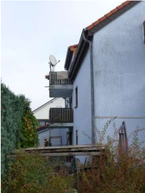
13 a Wohnhaus B (Nordwestseite)
