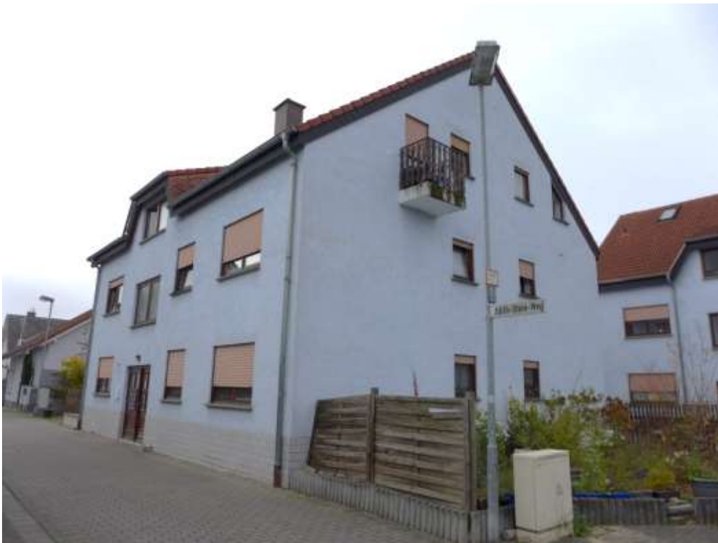
2 Wohnhaus A (Ostansicht)
