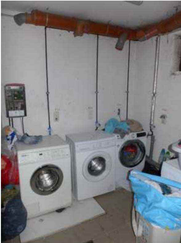
25 a Waschküche Keller Wohnhaus A
