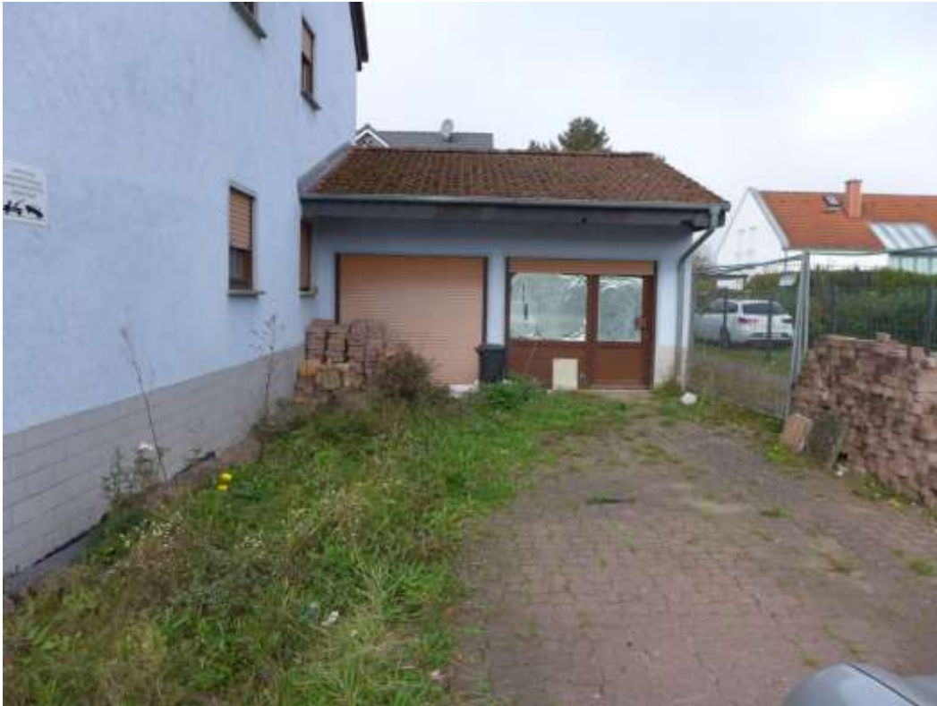
17 Doppelgarage mit vorliegender Sondernutzungsfläche
