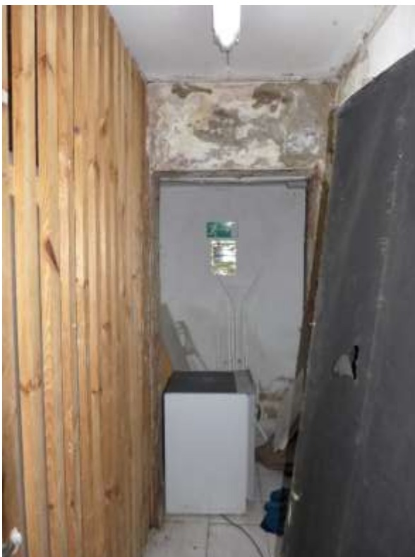
22 a Zustand Kellerflur Wohnhaus A
