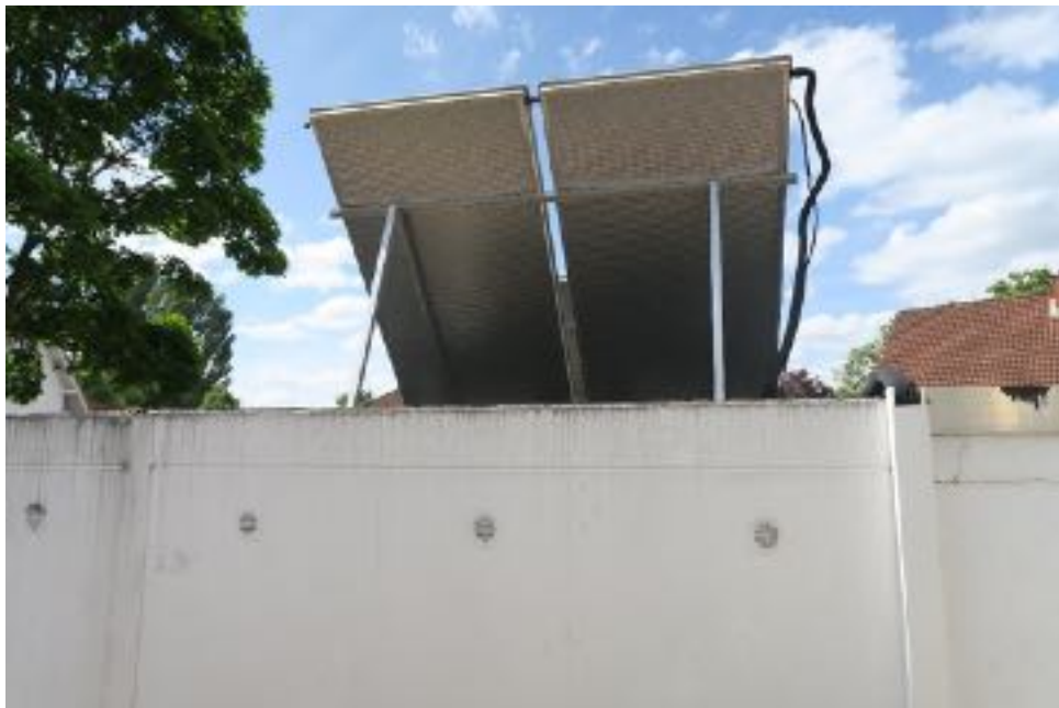
Bild 8: Rückansicht des Bewertungsobjekts (Garage mit Solarkollektoren)
