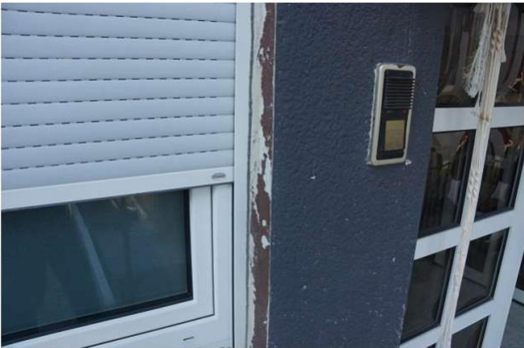
Bild-Nr. 24: Schäden: Putzabplatzungen
