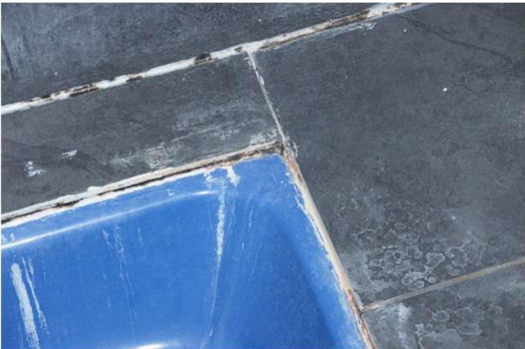
Bild-Nr. 26: Schäden: unzureichend verfugte Fliesen
