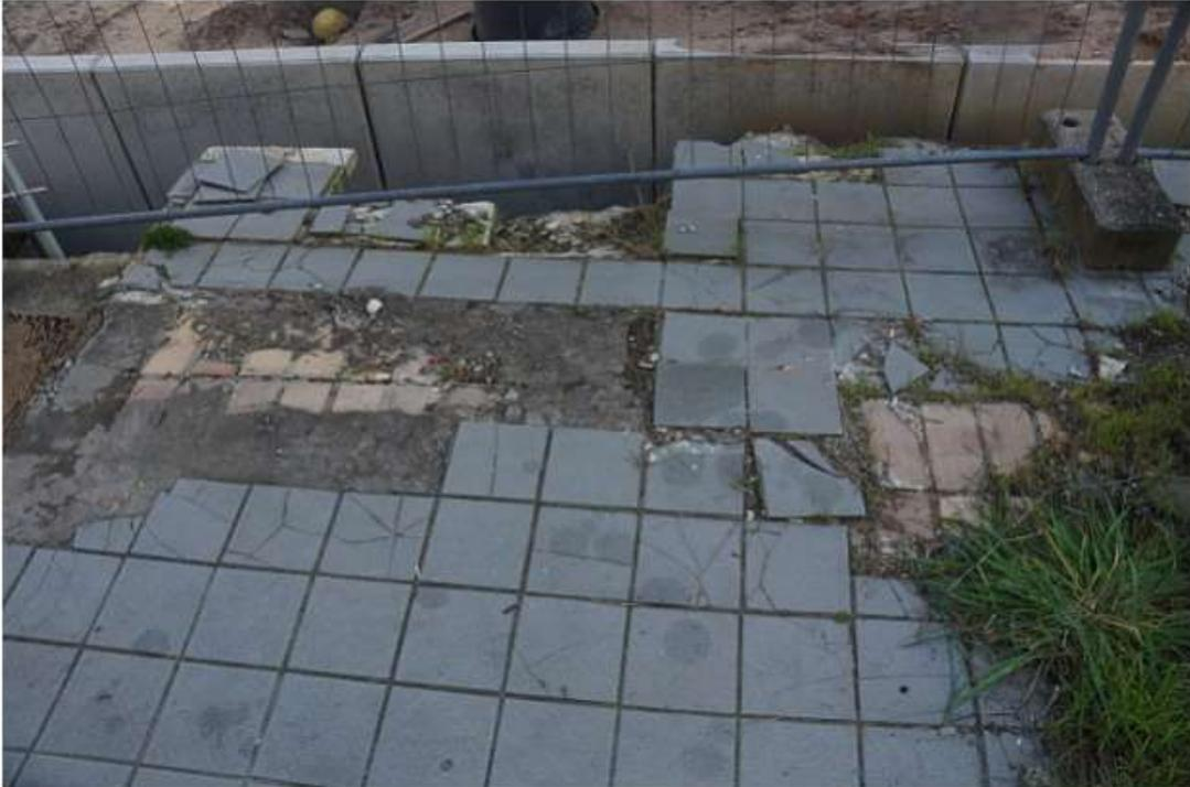
Bild-Nr. 23: Schäden: loser Wegbelag
