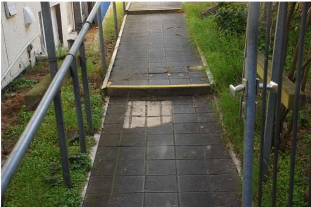
Bild-Nr. 22: Schäden: loser Wegbelag
