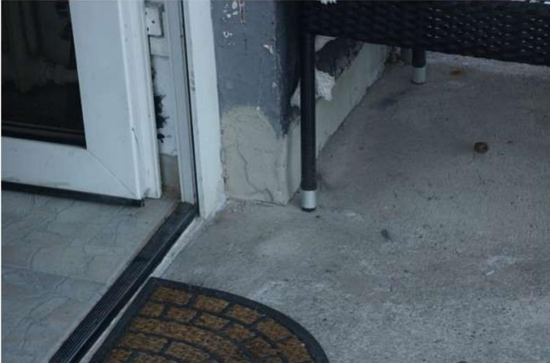
Bild-Nr. 25: Schäden: Putzabplatzungen und fehlender Eingangsbelag
