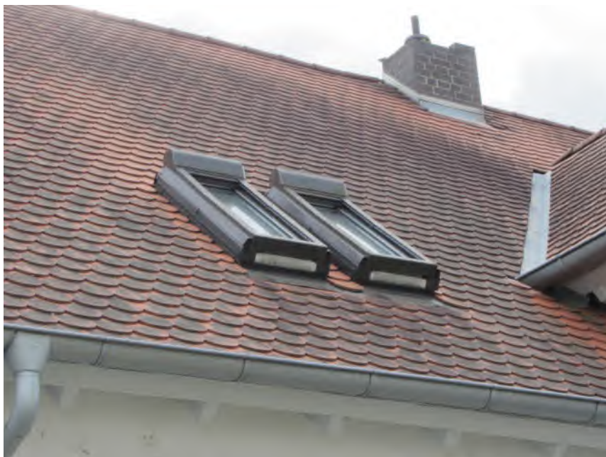
Bild 8: Zustand Biberschwanz- Eindeckung
