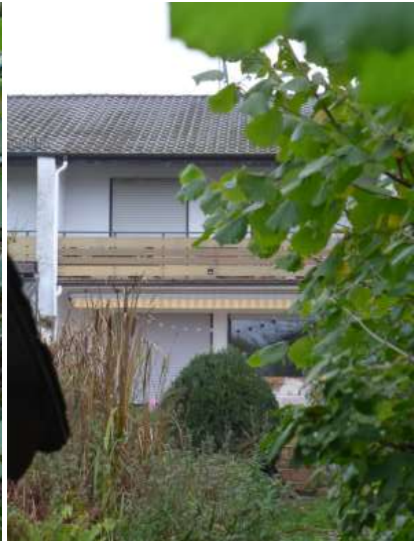
9 b Gebäuderückansicht (Westseite)
