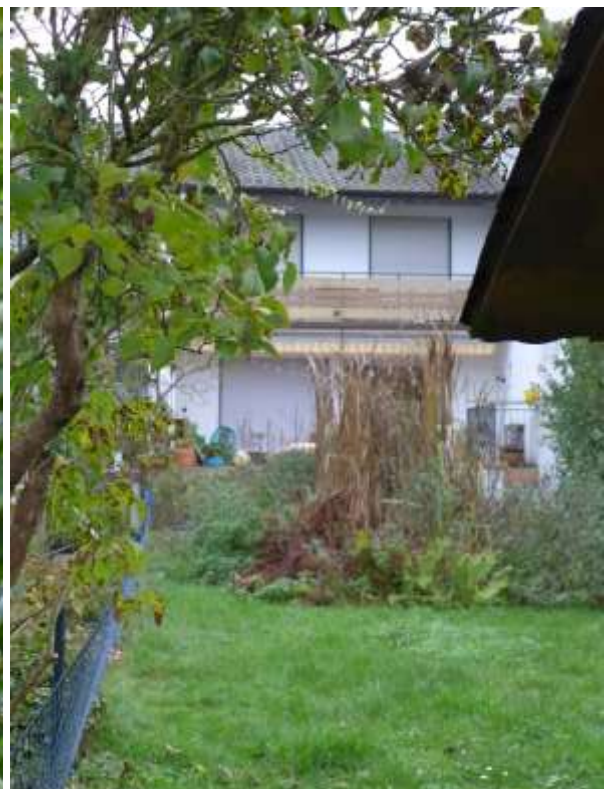
10 b Gebäuderückansicht (Westseite)
