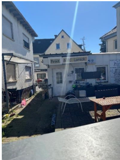
Nebengebäude (möglicherweise gewerbliche Nutzung)
