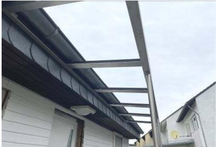
**Abb. 3:** Foto des SV; fehlende Verglasung der Eingangsüberdachung
