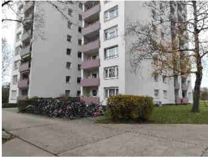
Bild 3: Hoffläche vor dem Objekt Taunusstraße 8
