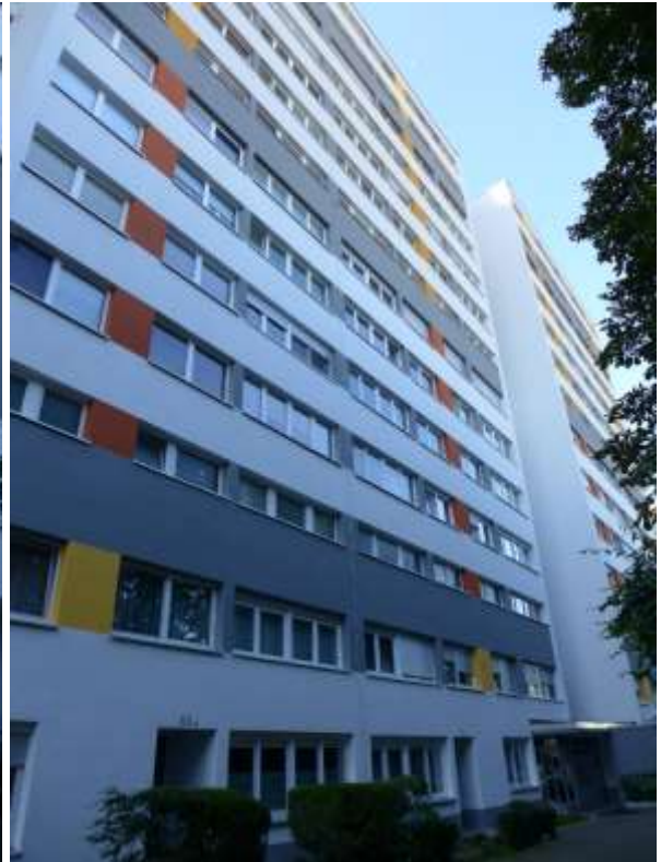
7 b Fassadenansicht Haus Nr. 86
