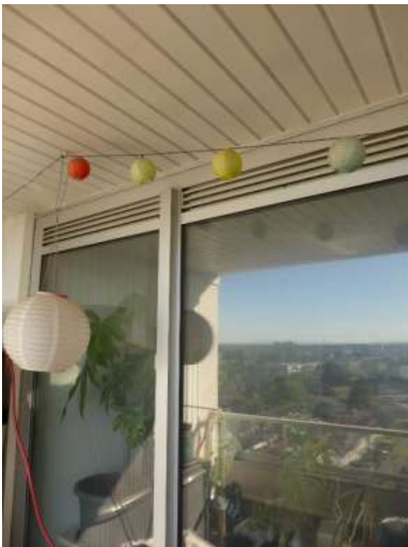
18 alte Aluminiumfenster an der Terrassenseite
