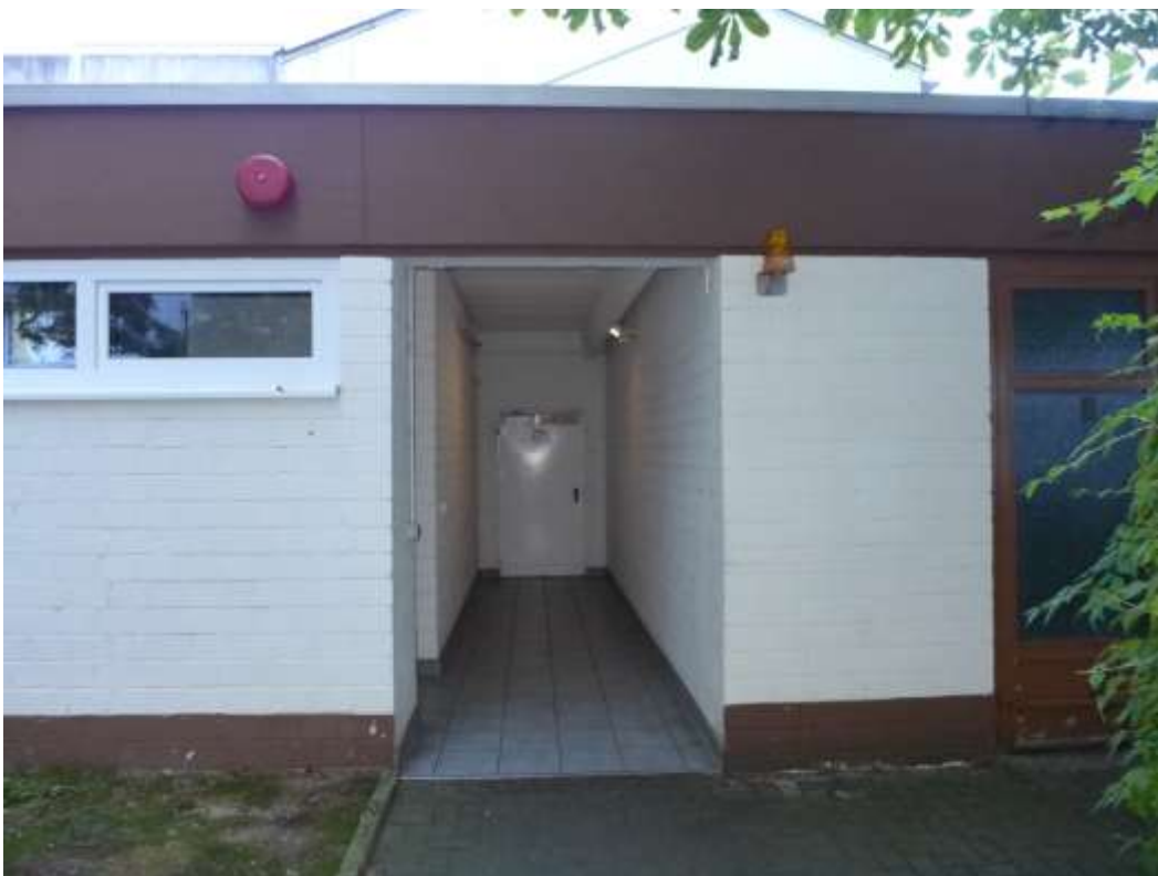
6 Zugang Tiefgarage, Waschküche
