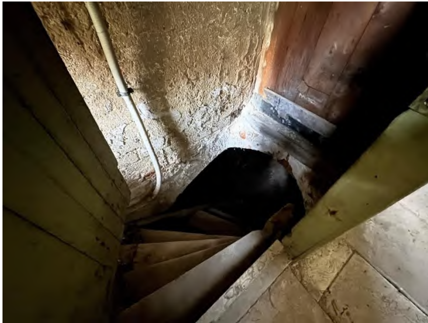
Bild 7: Treppe von Erdgeschoss (Wohngebäudeteil) zum Kellergeschoss
