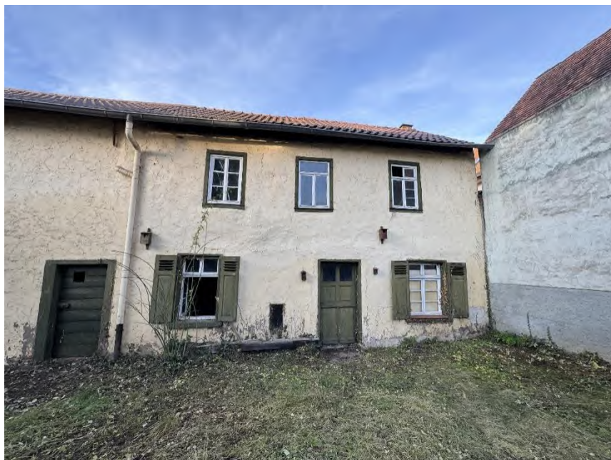
Bild 2: Gebäudeansicht (Wohngebäudeteil) von Süden
