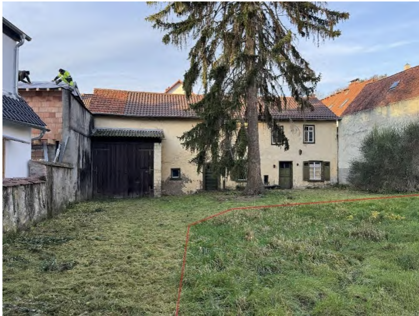
Bild 1: Gebäudeansicht von Süden
