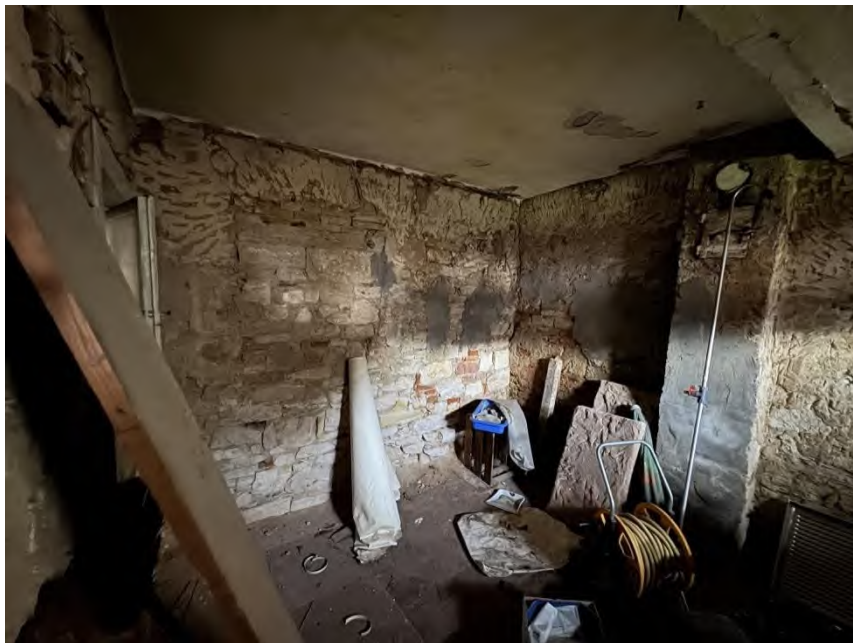
Bild 6: Raum Nr. 2 im Erdgeschoss (Wohngebäudeteil)
