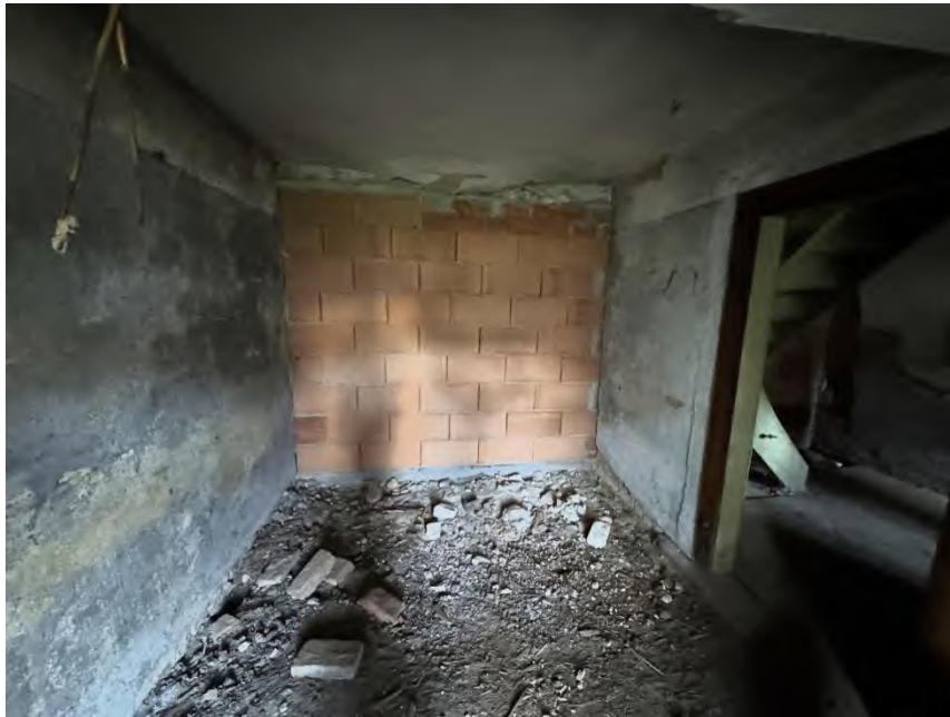
Bild 5: Raum Nr. 1 im Erdgeschoss (Wohngebäudeteil)
