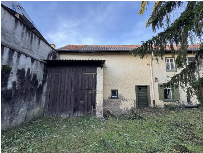
Bild 3: Gebäudeansicht (Wirtschaftsgebäudeteil) von Süden
