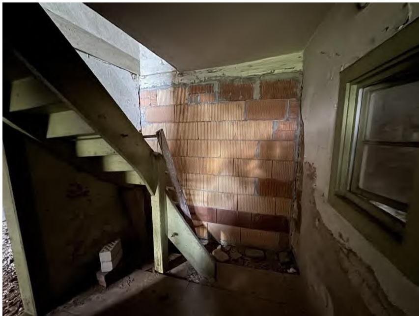
Bild 4: Flur im Erdgeschoss (Wohngebäudeteil) mit Treppe zum Obergeschoss
