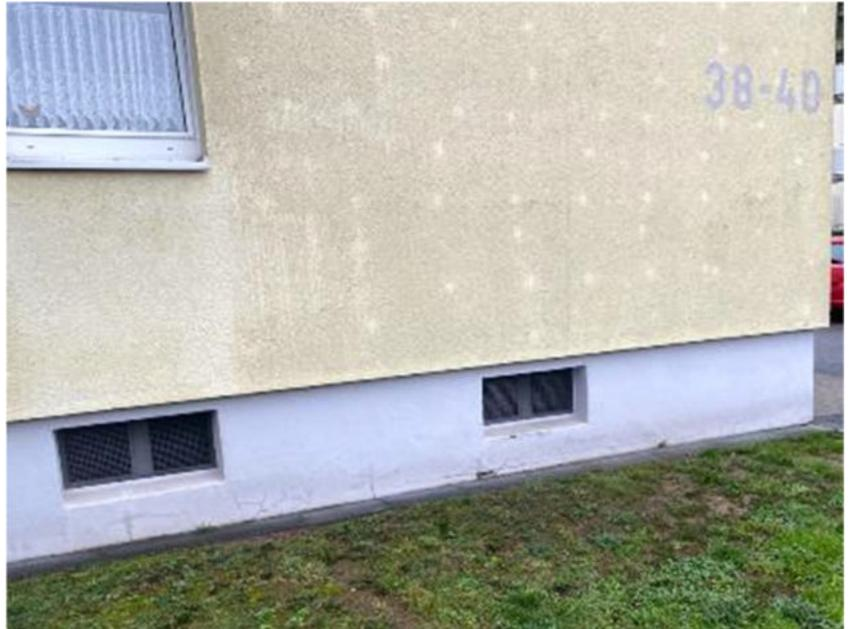
**Abb. 4:** Foto des SV; z.T. Fassade schadhaft (Putzverfärbungen, Dübelabzeichnungen des WDVS, Putzrisse im Sockelbereich)
