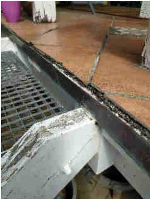
Bild 9: Sanierungsbedarf der Terrasse
