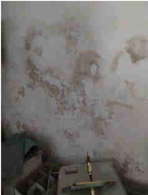
Bild 17: Putzschäden an den Kellerwänden
