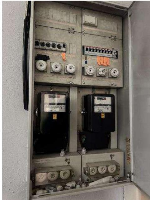
Bild 17: Sicherungskasten im Erdgeschoss
