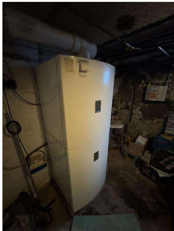
Bild 28: Brennwerttherme im Kellergeschoss
