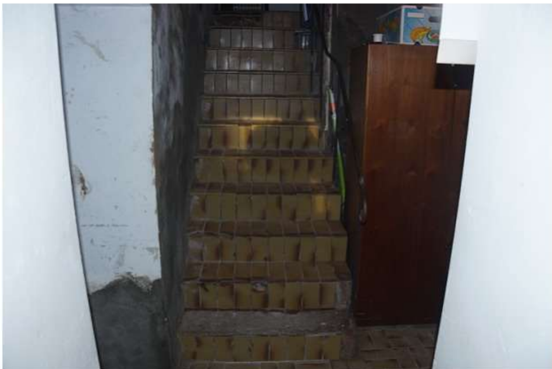
Bild-Nr. 46: defekte oder fehlende Fliesen Kellertreppe
