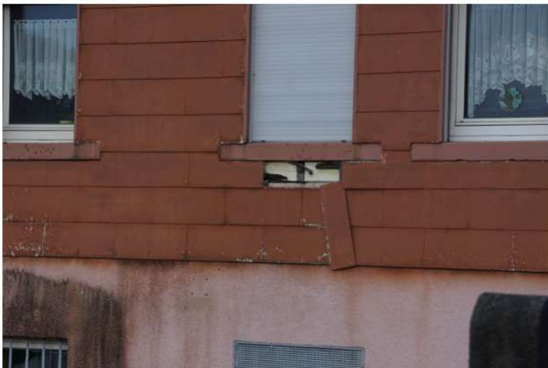
Bild-Nr. 39: Lose Fassadenverkleidung
