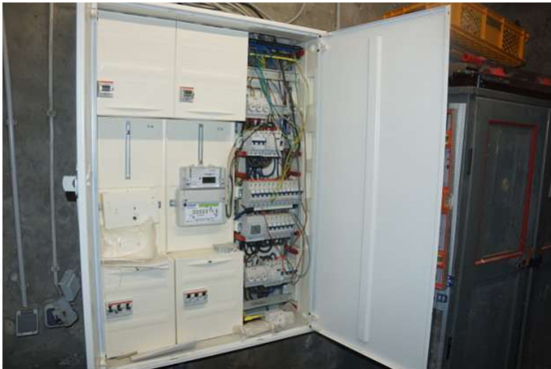
Bild-Nr. 42: nicht fertig installierte Elektrik
