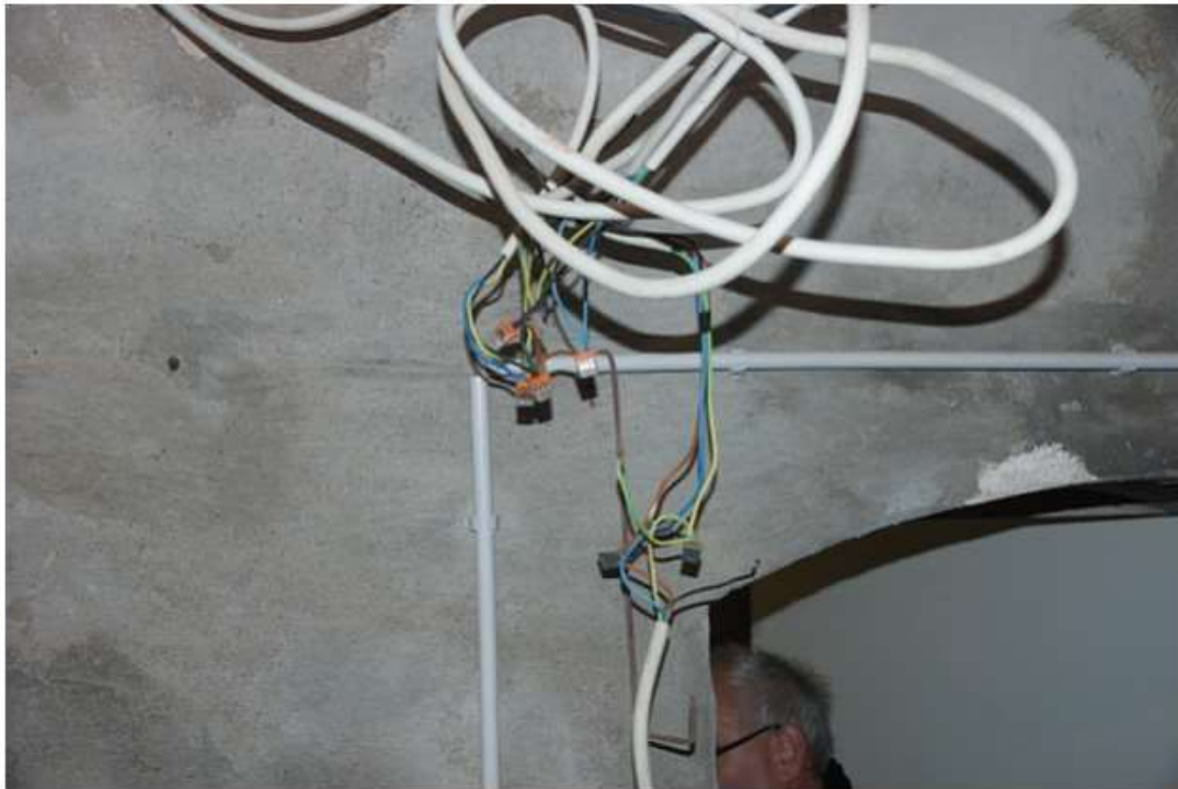
Bild-Nr. 43: nicht fertig installierte Elektrik
