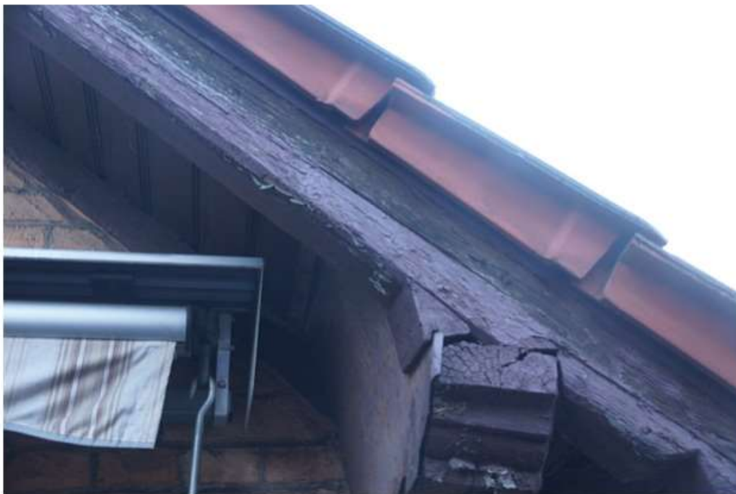
Bild-Nr. 40: vewitterter Dachbalken
