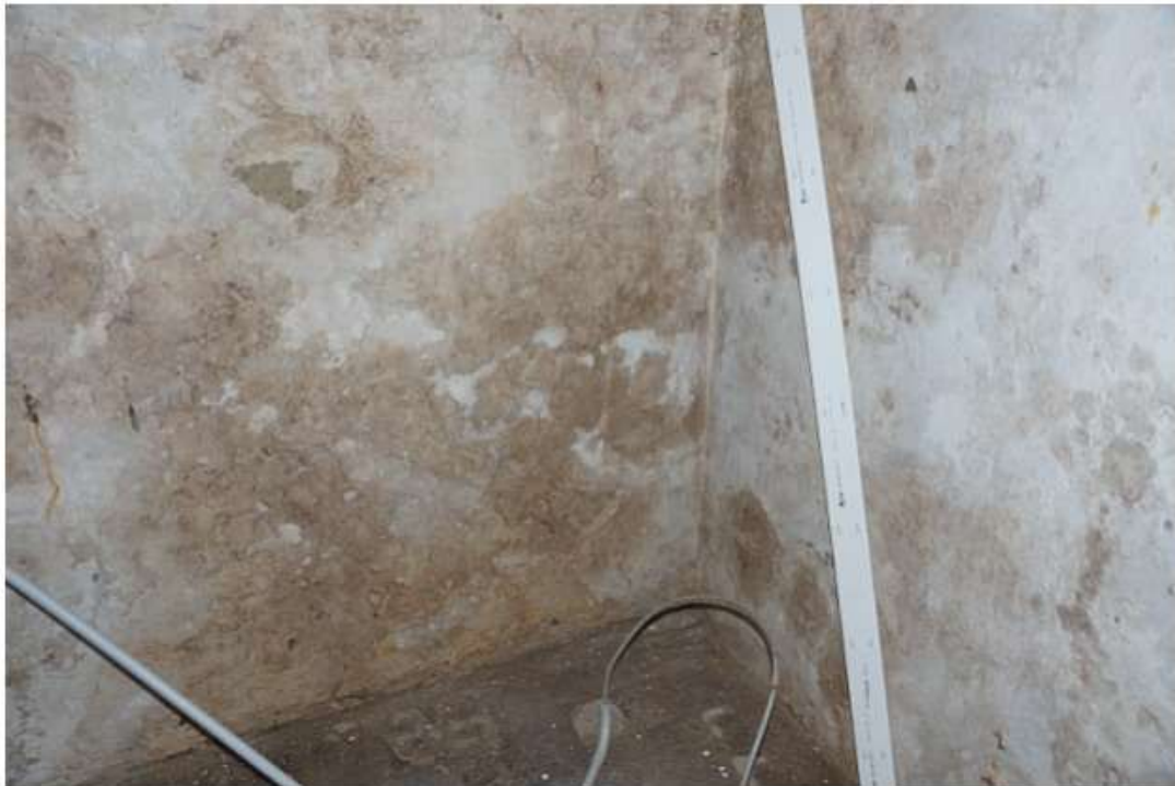
Bild-Nr. 45: Feuchteschäden Kelleraußenwand
