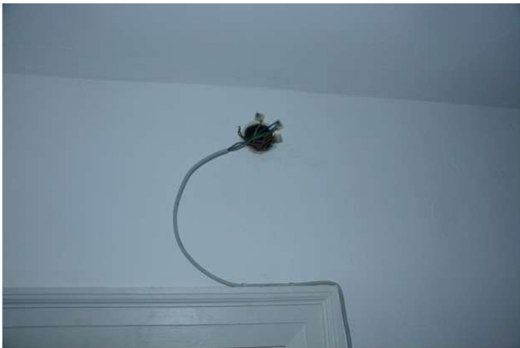
Bild-Nr. 48: offene Verteilerdose
