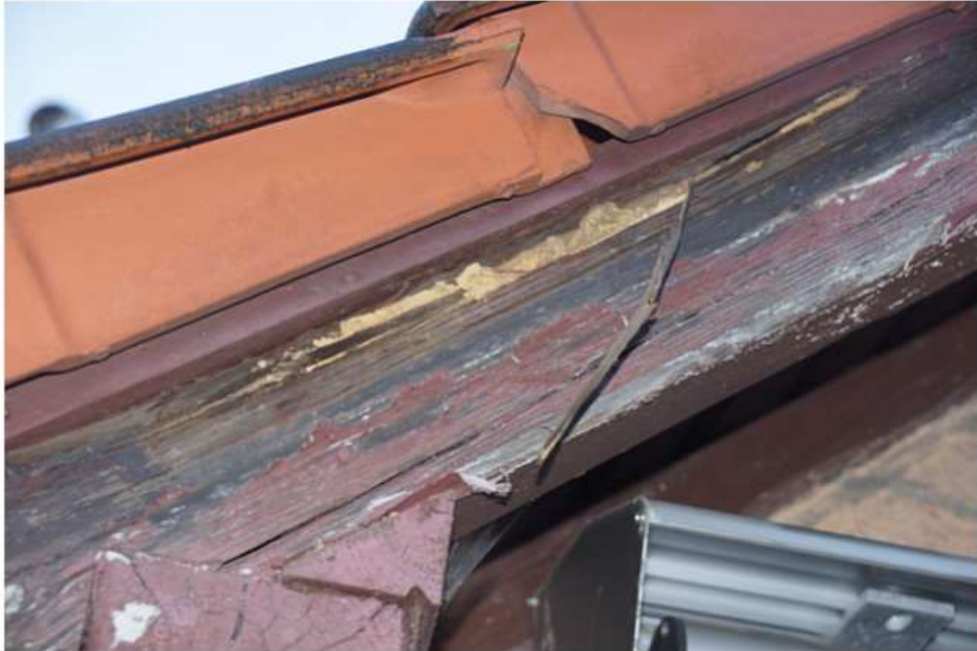
Bild-Nr. 41: Verwitterter Dachbalken
