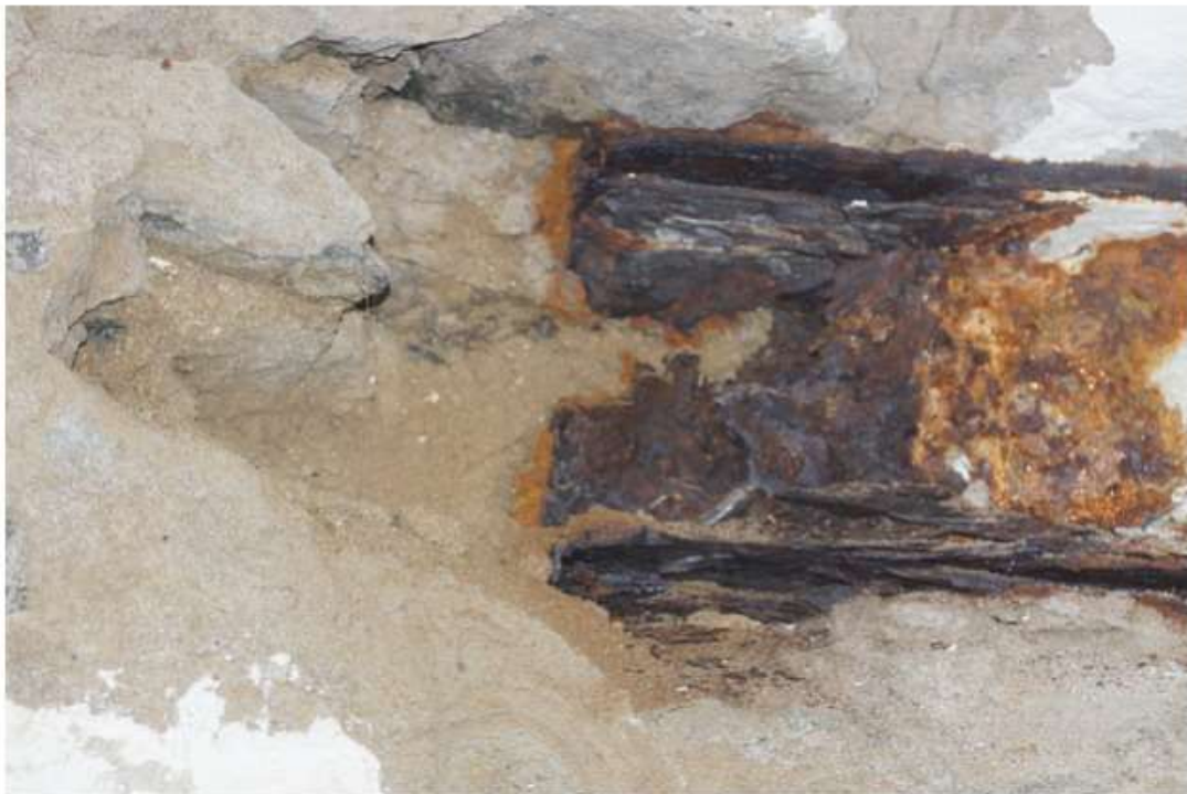
Bild-Nr. 44: stark verrosteter Stahlträger
