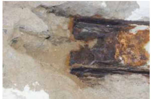
Bild 6: defekter Sockel
