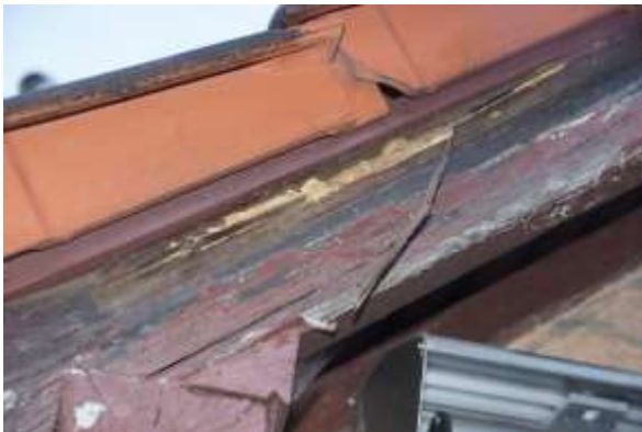
Bild 5: defekter Sockel
