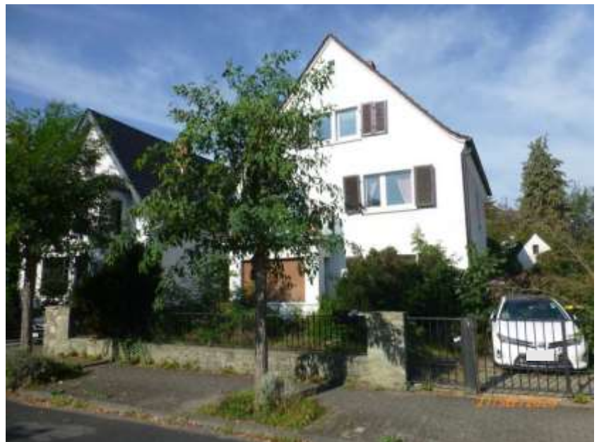
Ansicht von Süd-Osten
