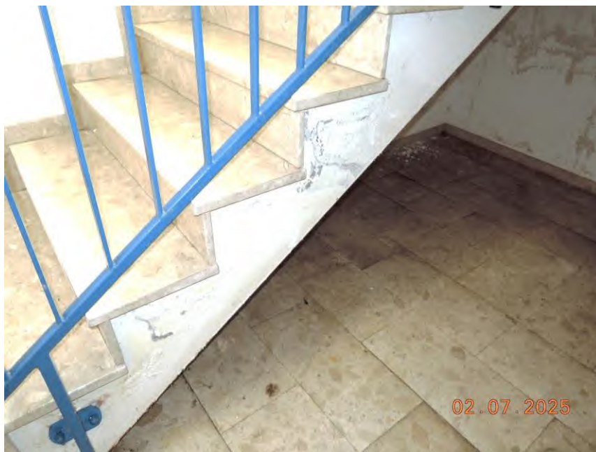
Abb. 8: Feuchtigkeitsschäden im Kellergeschoss
