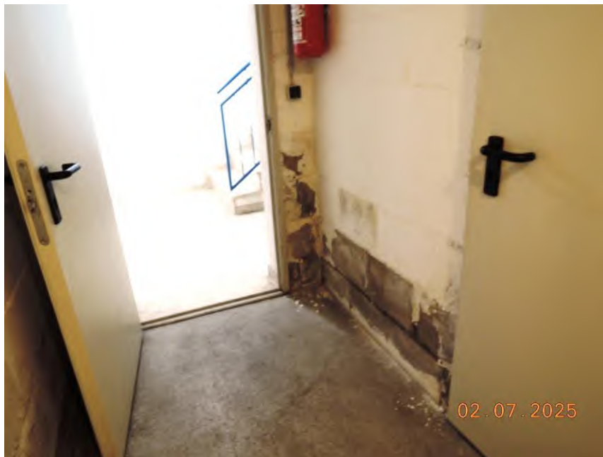
Abb. 7: Flur im Keller, Feuchtigkeitsschäden
