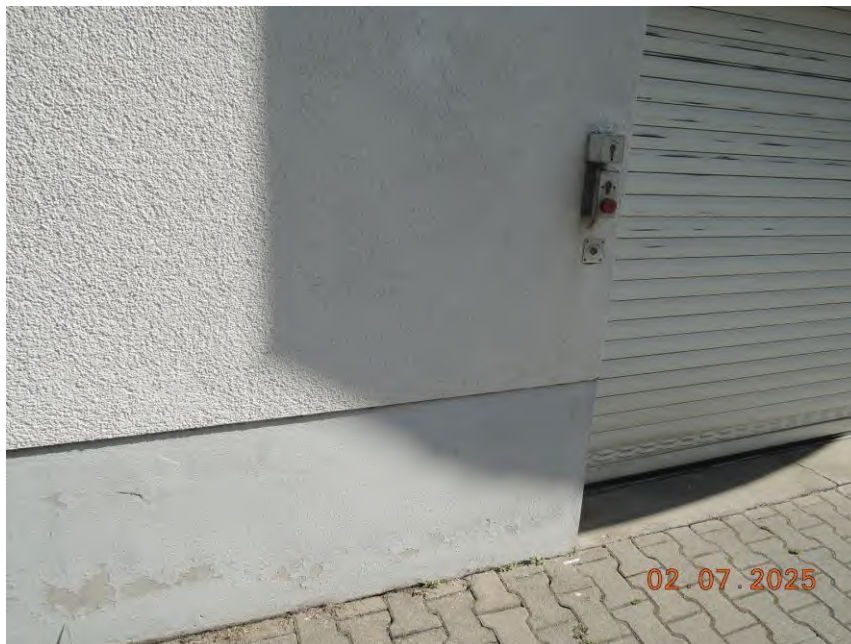
Abb. 10: Feuchtigkeitsschäden im Bereich des Sockels (Straßenseite)
