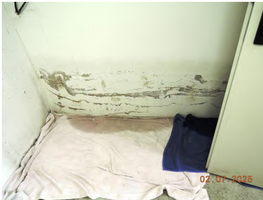
Abb. 9: Feuchtigkeitsschäden im Kellergeschoss
