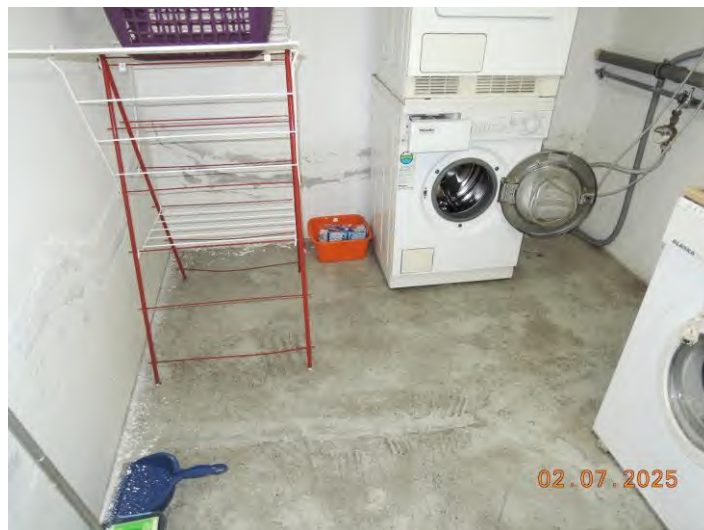
Abb. 6: Wasch- und Trockenraum, Feuchtigkeitsschäden
