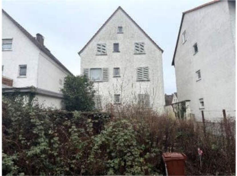
Foto 3 des SV: Ansicht von Nordosten, vom Garten; Gebäuderückseite
