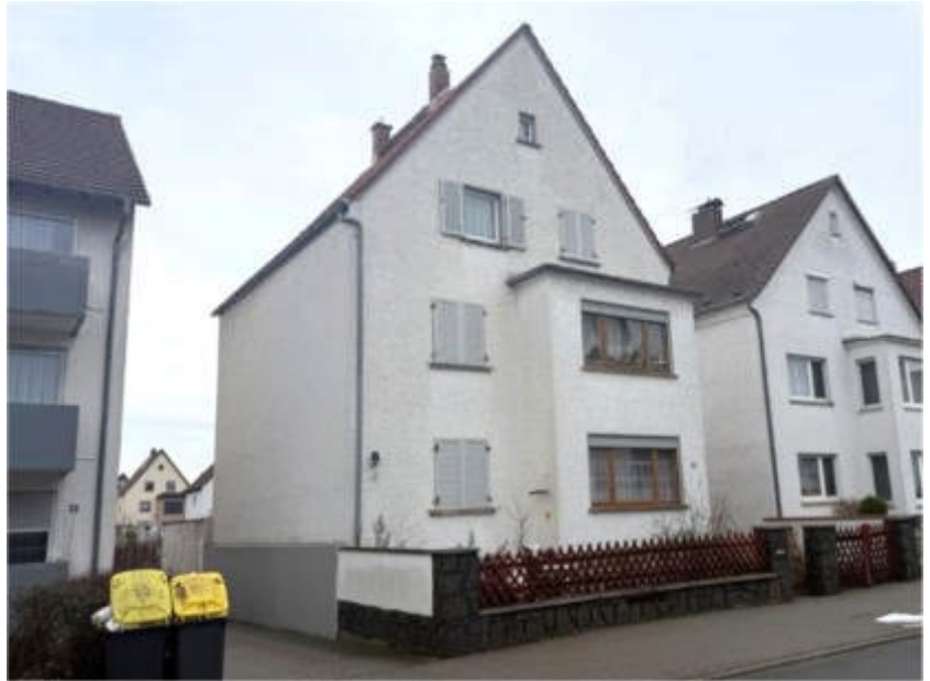
Foto 1 des SV: Ansicht von Südwesten, Straßenansicht
