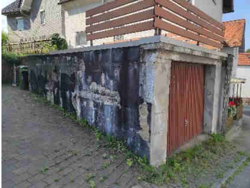
Bild 3: Ansicht der abbruchreifen Garage
