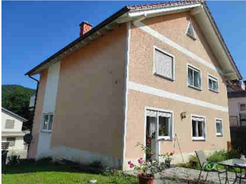
Bild 1: Ansicht nach Süden
