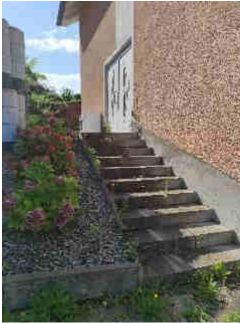
Bild 5: Treppe zum Hauseingang
