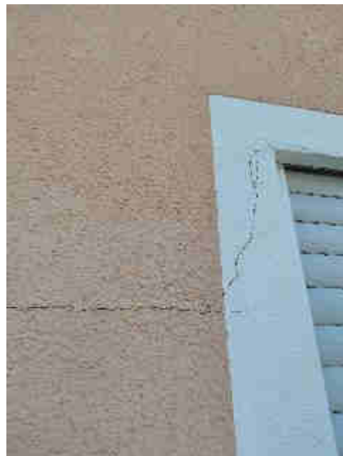
Bild 12: diverse Fassadenrisse
