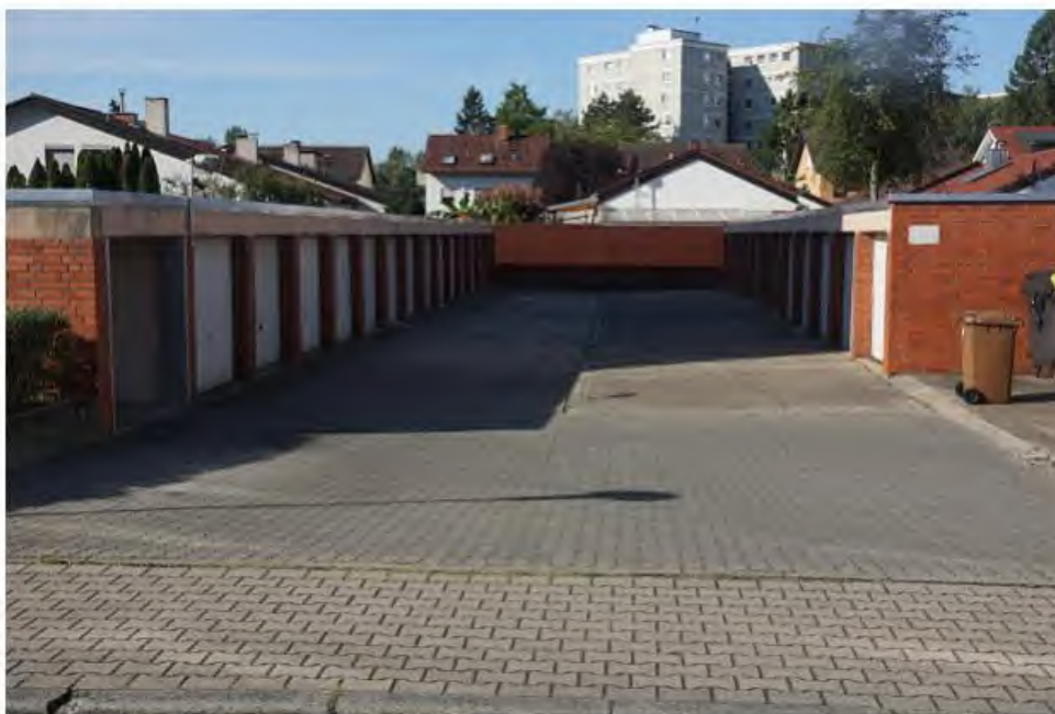
Bild-Nr. 1: Garagenanlage Blick von der Straße
