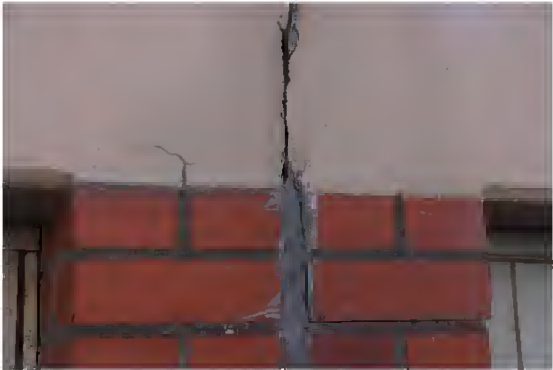
Bild-Nr 6 Dichtungsschäden
