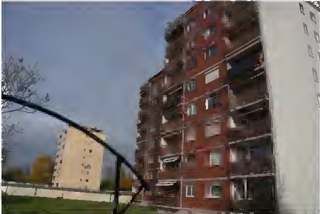
Bild-Nr 3 Rückseite Mehrfamilienwohnhaus
