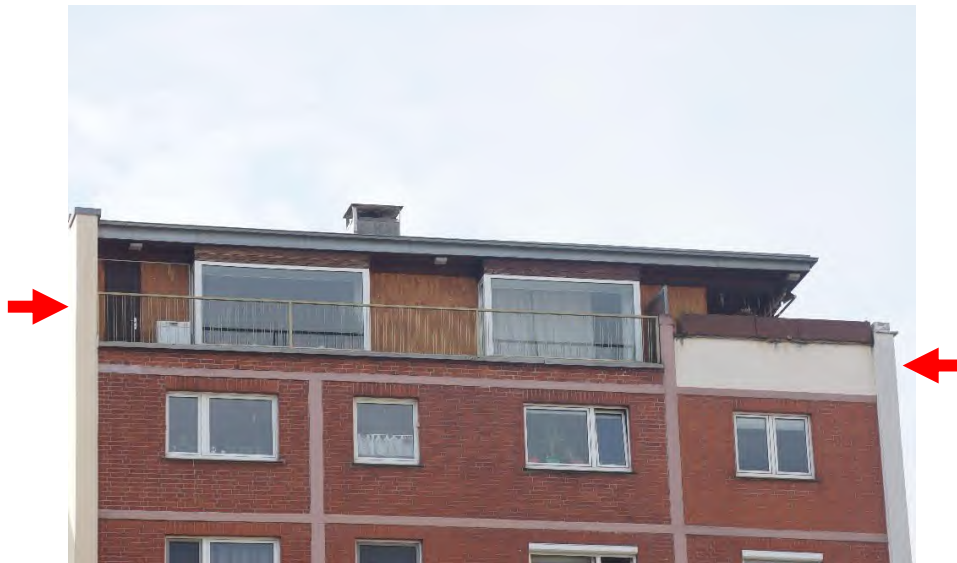
Straßenansicht der Eigentumswohnung (zwischen den Pfeilen)
