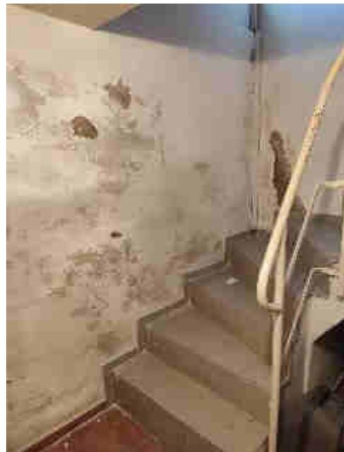
Bild 18: Nässe- und Putzschäden im Keller
