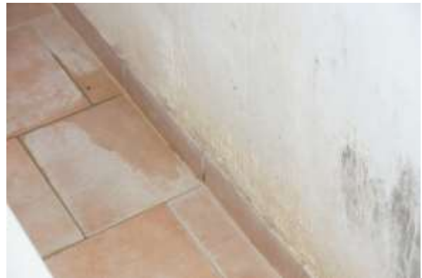
Bild 6: Feuchteschäden
