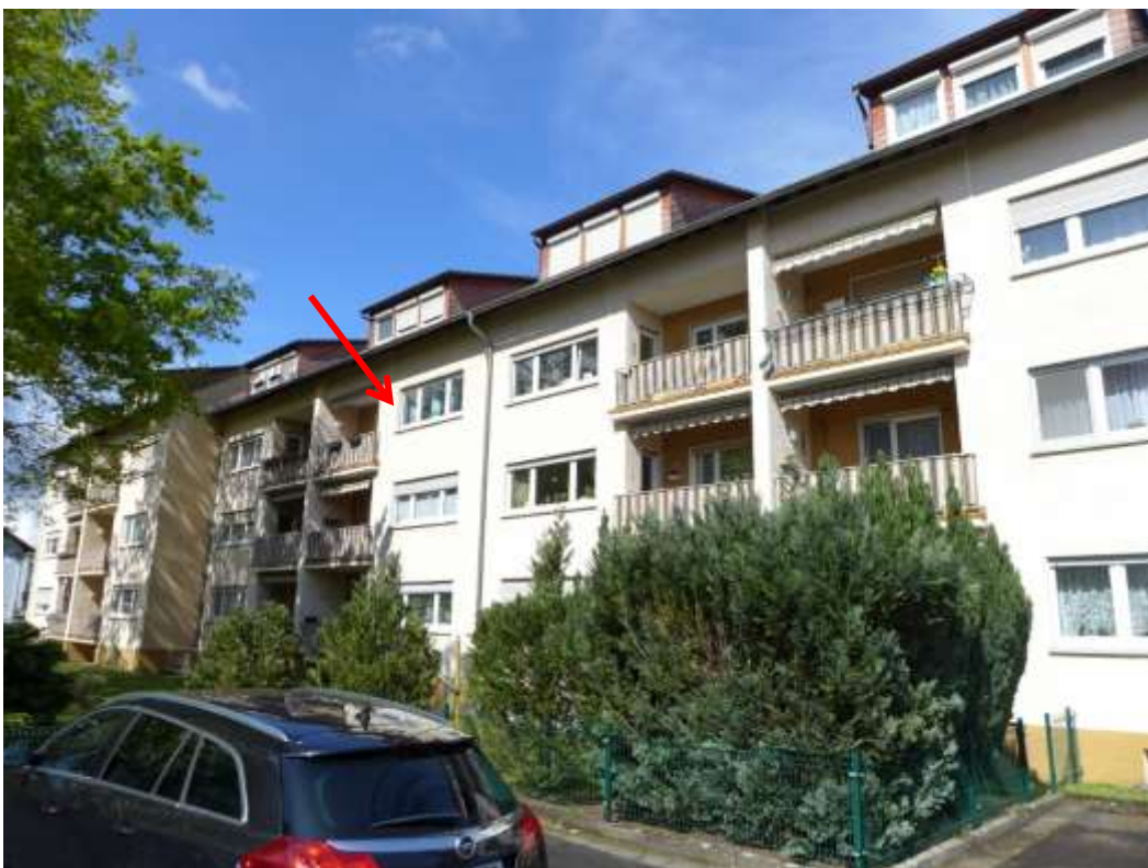
6 Südwestansicht, Bewertungsobjekt markiert
