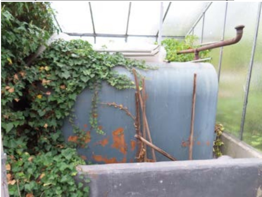
Abbildung 39: Blick auf einen alten Öltank der alten Heizanlage
