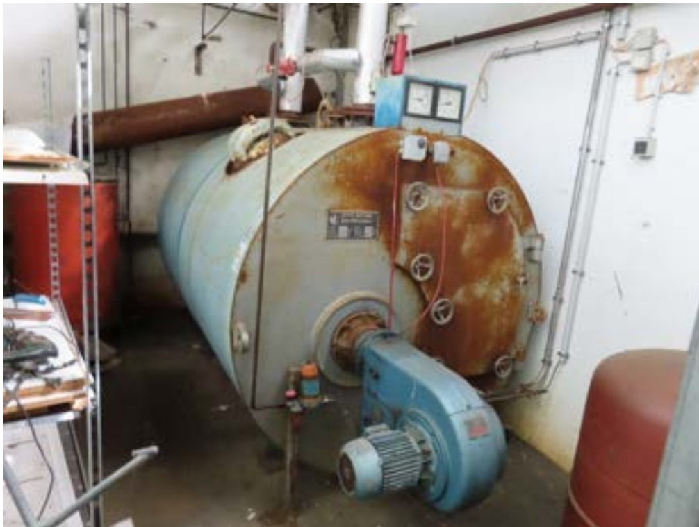
Abbildung 26: Kessel der Heizung
