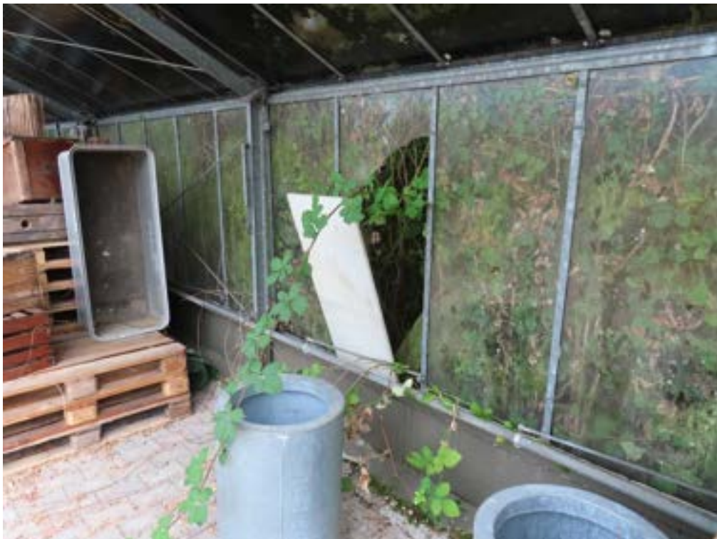
Abbildung 41: Blick auf die nördliche Seitenwand mit Glasbruch
