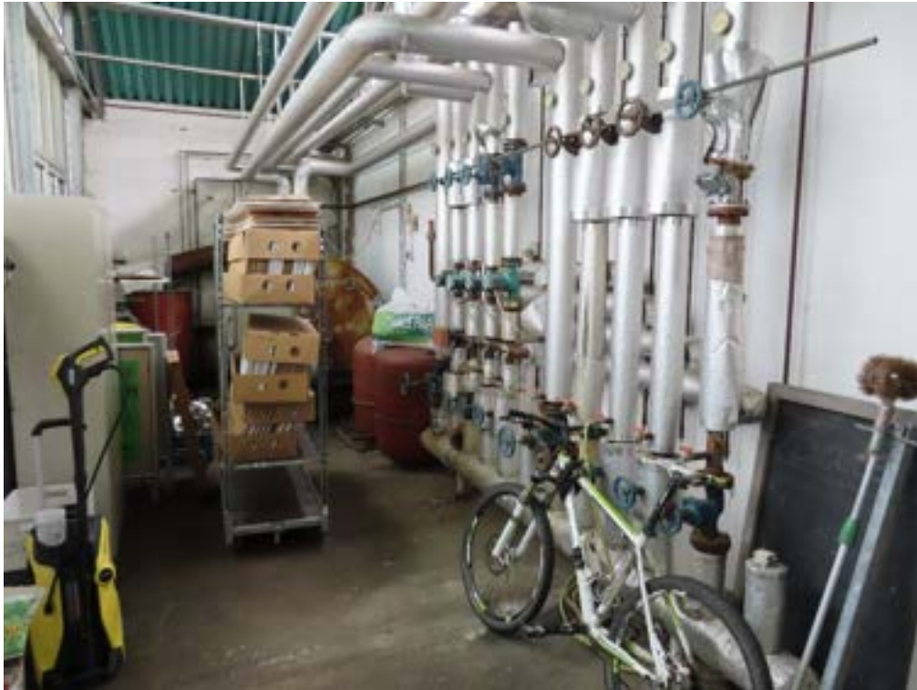
Abbildung 25: Blick auf Rohrinstallationen im Anschlussraum; im hinteren Bereich ist ein Teil der Heizanlage ersichtlich
