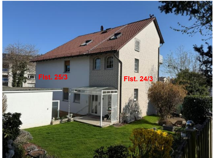
Foto 3 des SV: Ansicht von Nordwesten, von der Straße Maulbeerweg, Gebäude (auf Flst. 25/3) mit Treppenhausanbau (auf Flst. 24/3)
