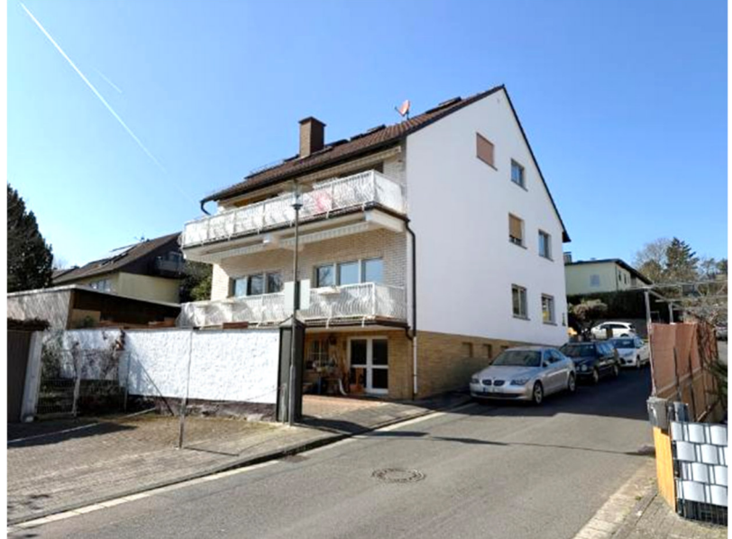
Foto 1 des SV: Gebäudeansicht von Südosten, von der Görlitzer Straße
