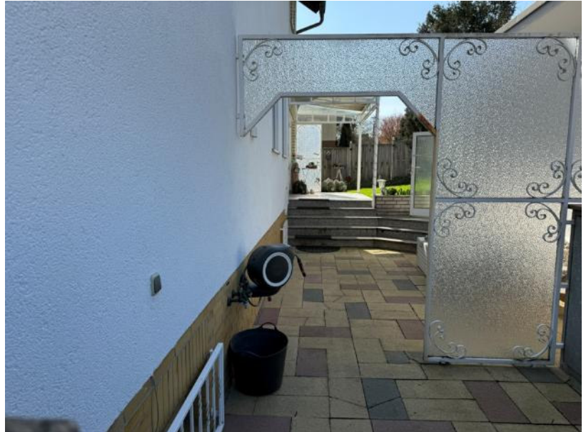
Foto 5 des SV: Ansicht von Westen; Hauseingang, Zugang zum Treppenhauseingangsbereich auf Flst. 24/3
