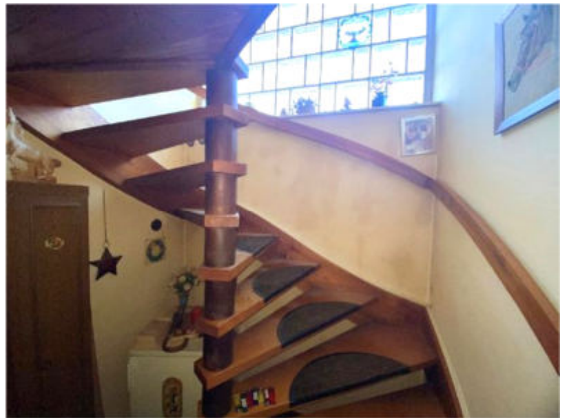
Foto 8 des SV: Untergeschoss; Treppenraum UG-EG
