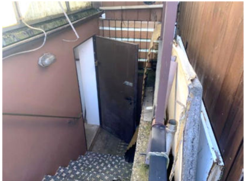
Foto 16 des SV: Zugang von der Garage zum Garten
