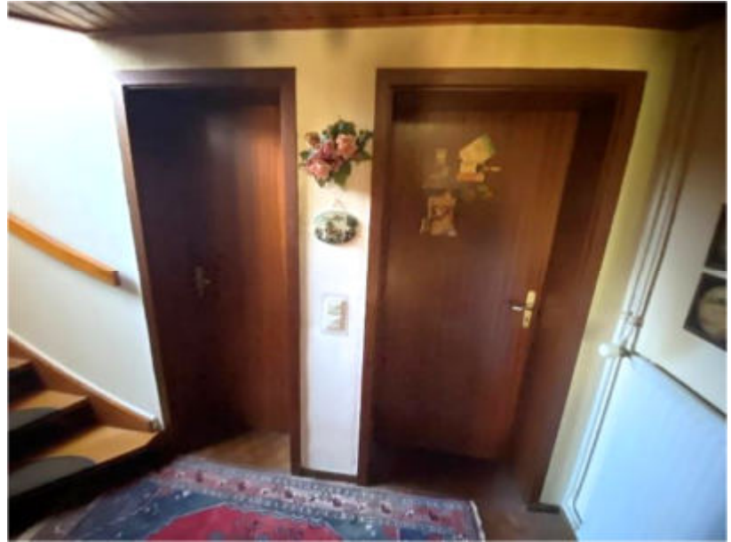
Foto 7 des SV: Untergeschoss; Zugang zu Wohnraum und Kellerräumen
