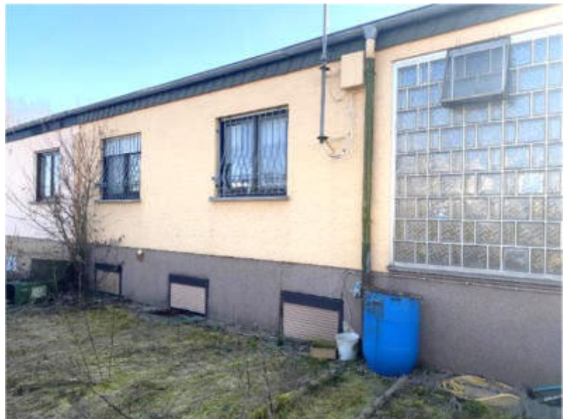
Foto 4 des SV: Ansicht von Nordwesten, Hausrückseite
