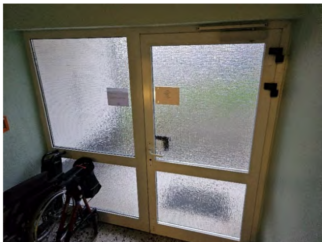
Hauseingangstüre (Haus Nr. 36) (Leichtmetall mit Strukturglas)
