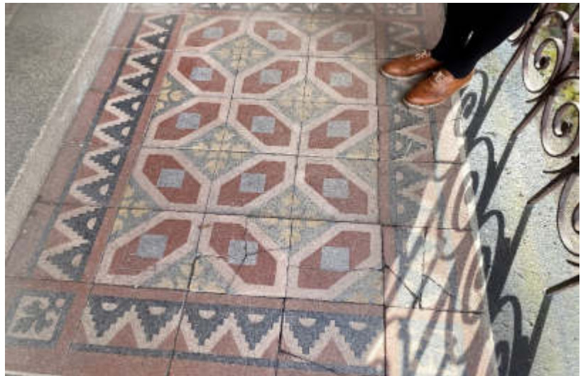
Abb. 4: Foto des SV; z.T. Fliesenschäden (Risse) im Eingangsbereich (Straßenseite)
