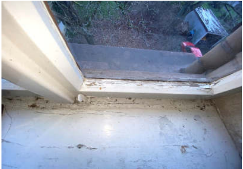
Abb. 18: Foto des SV; z.T. Holzwerk an Fenstern überholungsbedürftig (Treppenhaus)
