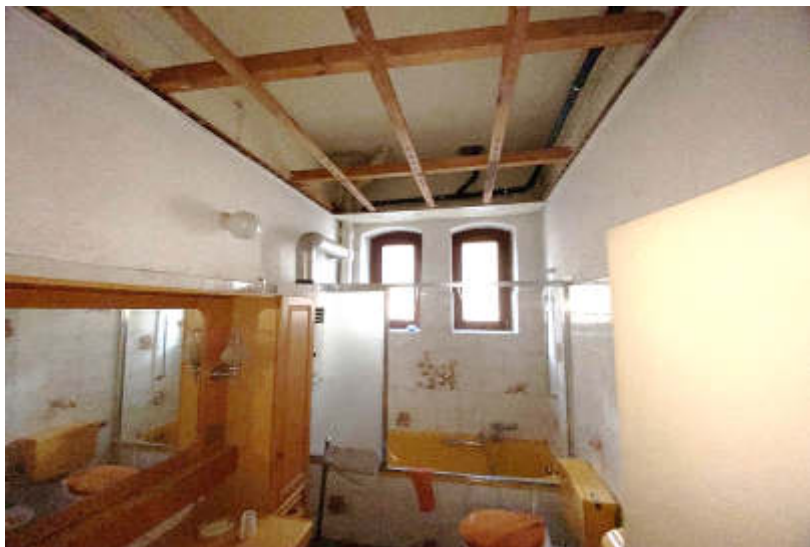
Abb. 6: Foto des SV; z.T. Deckenbekleidung unvollständig (EG)
