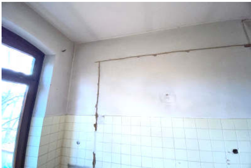
Abb. 9: Foto des SV; z.T. Leitungsschlitze nicht verschlossen (OG)
