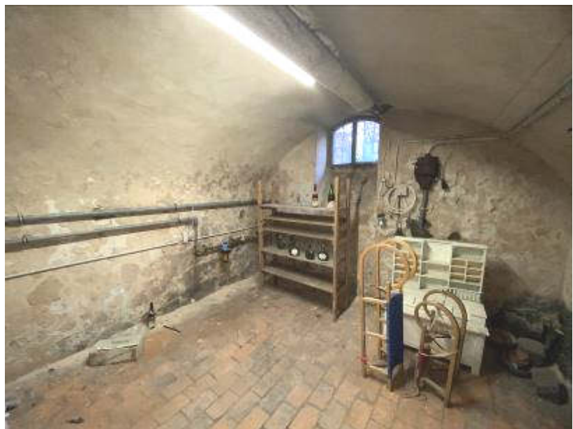
Abb. 21: Foto des SV; z.T. baujahres-/bauarttypische Feuchtschäden (KG)
