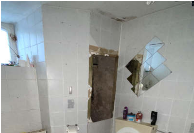
Abb. 15: Foto des SV; z.T. Wand-/Deckenbekleidungen schadhaft (KG)
