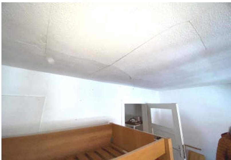
Abb. 11: Foto des SV; z.T. Deckenbekleidungen schadhaft (DG)
