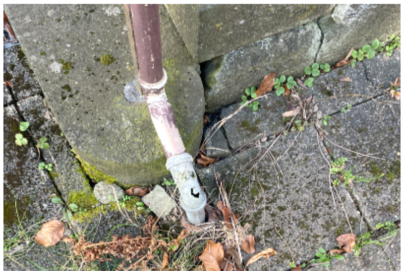
Abb. 5: Foto des SV; z. T. Fallrohre schadhaft
