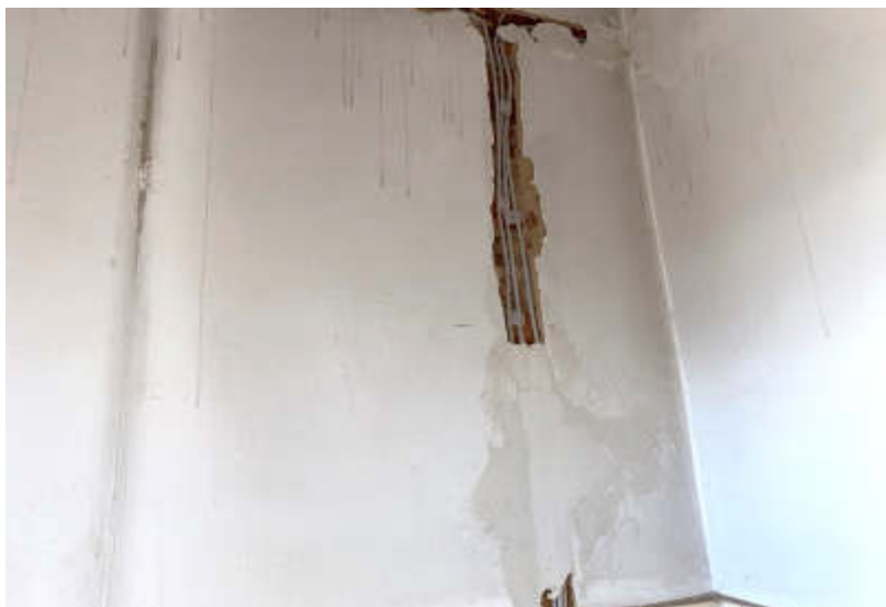
Abb. 10: Foto des SV; z.T. Wandbekleidung schadhaft; Leitungsschlitze nicht verschlossen (OG)
