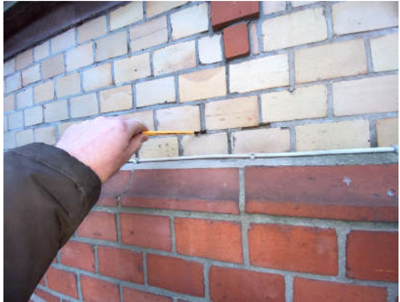
Abb. 20: Foto des SV; z. T. Fassade schadhaft (Fugenausbrüche)
