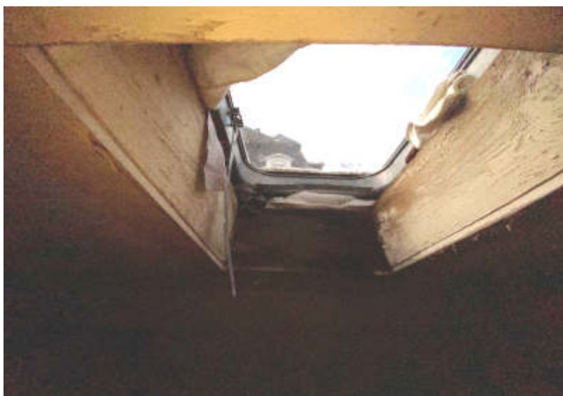
Abb. 17: Foto des SV; Dachfenster überaltert (DG)
