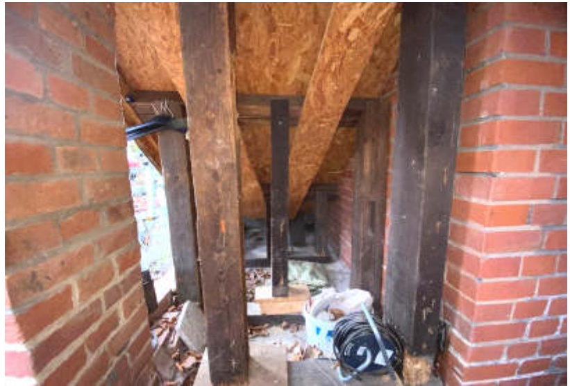
Abb. 3: Foto des SV; Eingangstreppe (Gartenseite) provisorisch abgestützt
