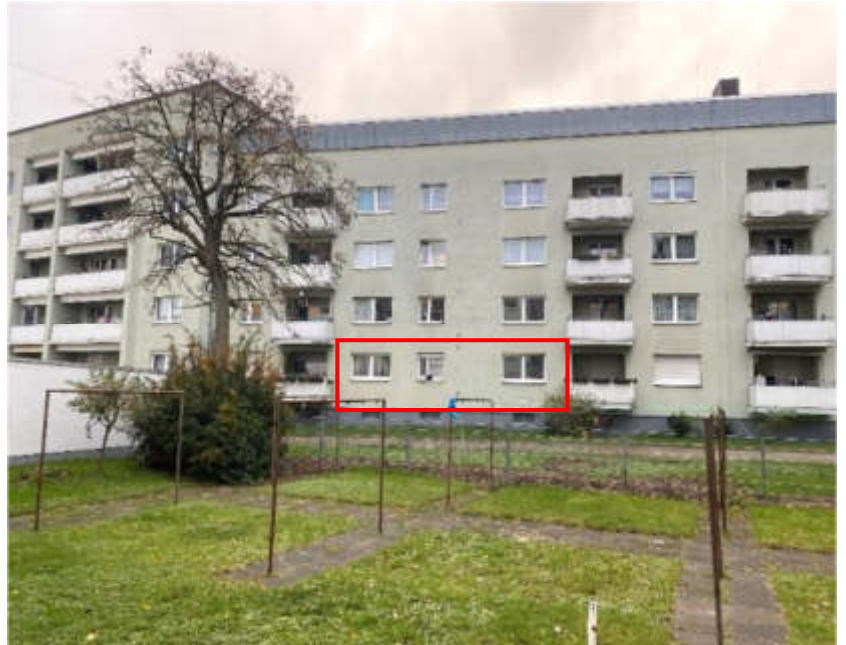
Foto 1 des SV: Beethovenstraße 12, Hausrückseite, Ansicht von Südwesten; Detail Wohnung Nr. 26; Roteintragung d.d. SV
