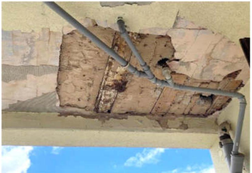
**Abb. 7:** Foto des SV; z.T. Unterseite der Hofdurchfahrt schadhaft
