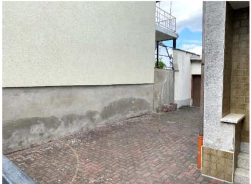
**Abb. 3:** Foto des SV; z.T. Fassade schadhaft; Putz-/Feuchteschäden im Sockelbereich
