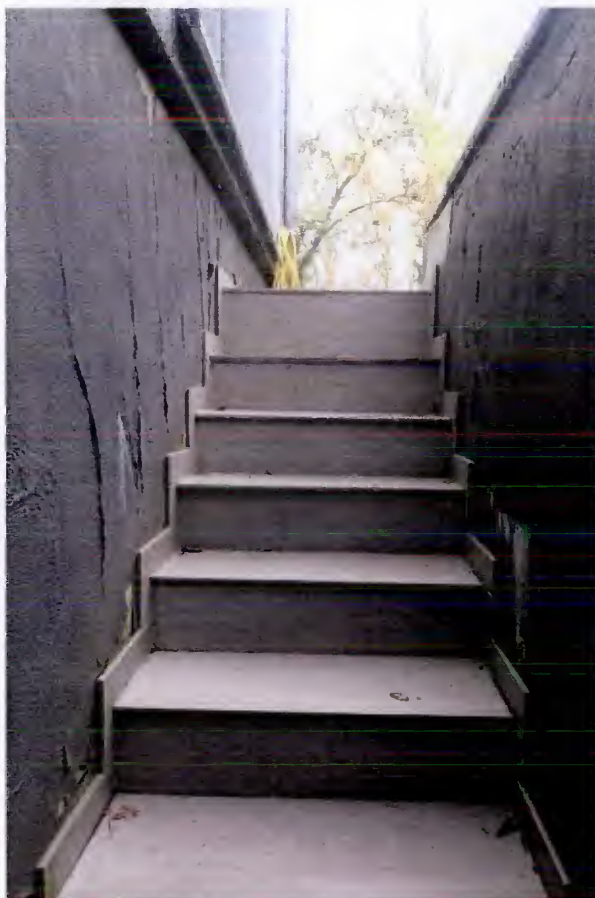
Abb. 54: Plattenbelag auf den Treppenstufen
