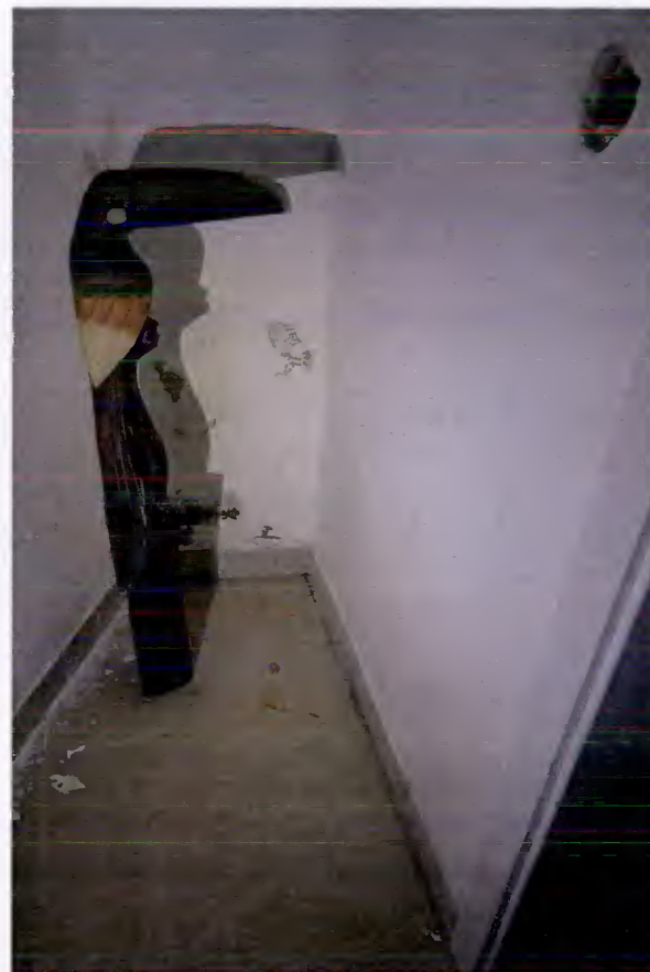
Abb. 43 u. 44: Feuchtflecke u. Ausblühungen auf Wänden des Flur sowie unter der Treppe
