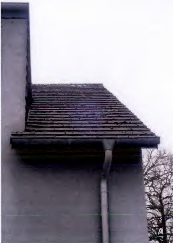
Abb. 7: Quergiebelwandanschluss u. eingeputzte Dachsteine
