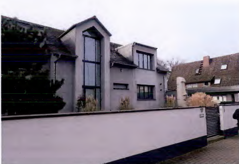
Abb. 1: Straßen-, Eingangs- und Nordansicht des Objektes Hochstädter Landstr. 17, Hanau
