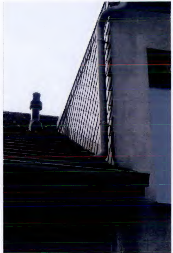
Abb. 6: Kamindurchführung, Quergiebelwandanschluss
