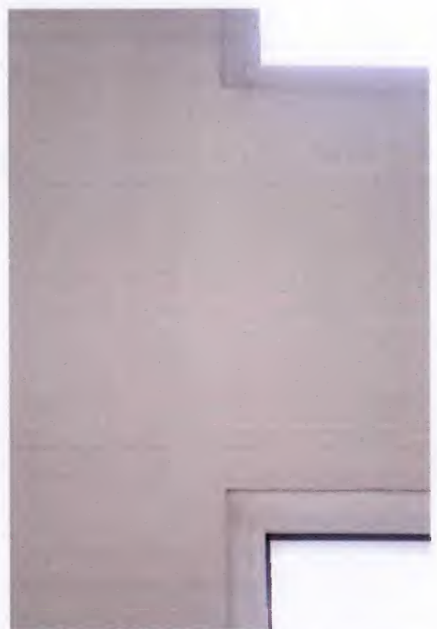
Abb. 18: Vertikalriss im Wohnzimmer des Festver- glasungssturzes
