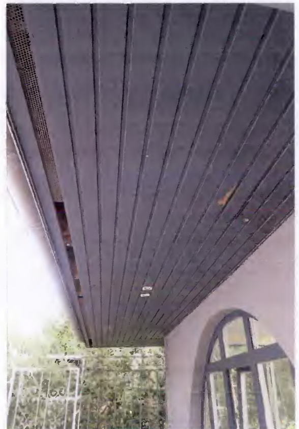
Abb. 66 u. 67: fehlendes Insektengitter in der Traufschalung u. Farbablösungen
