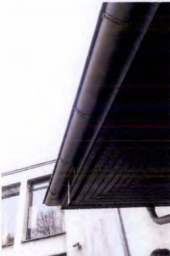
Abb. 66 u. 67: fehlendes Insektengitter in der Traufschalung u. Farbablösungen
