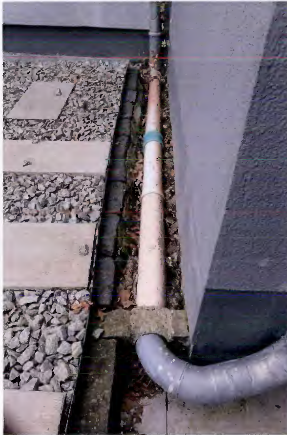
Abb. 58: nicht UV-beständiges Kanalgrundrohr
