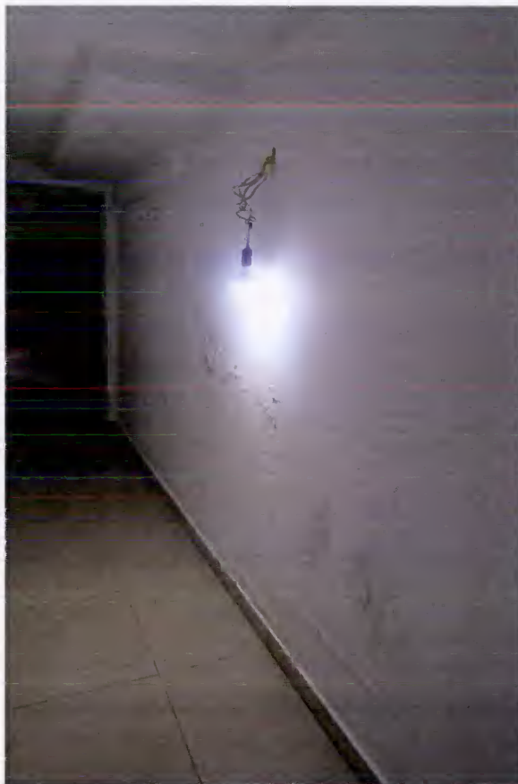
Abb. 43 u. 44: Feuchtflecke u. Ausblühungen auf Wänden des Flur sowie unter der Treppe
