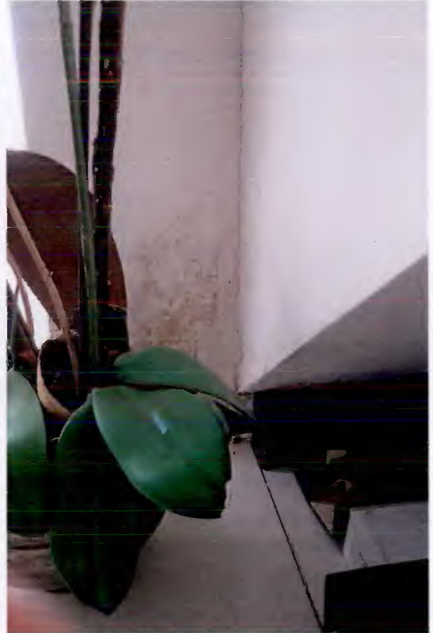
Abb. 26 u. 27: Feuchte- u. Schimmelpilzschäden am Ankleide-Quergiebelwandanschluss
