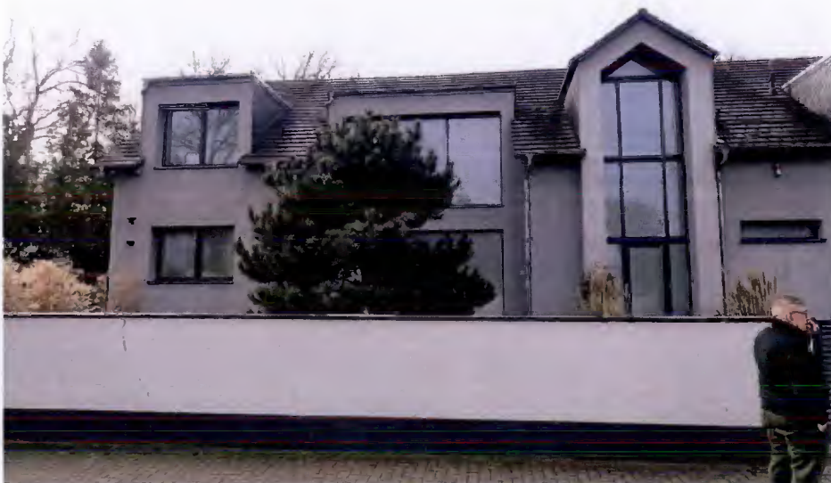
Abb. 2: Straßen-, Eingangs- und Nordansicht des Objektes Hochstädter Landstr. 17, Hanau
