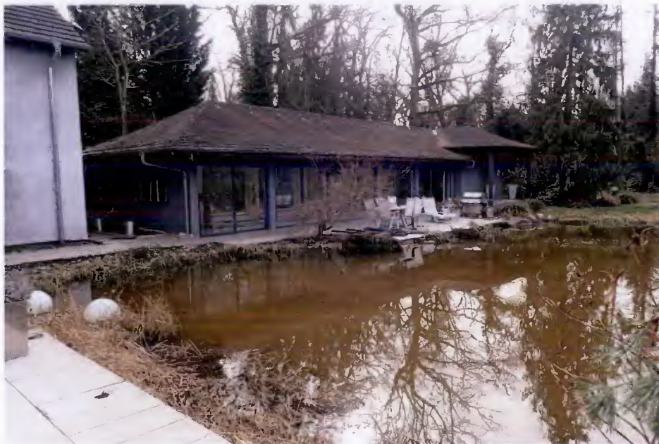
Abb. 4: Schwimmhalle mit flach geneigtem Walmdach
