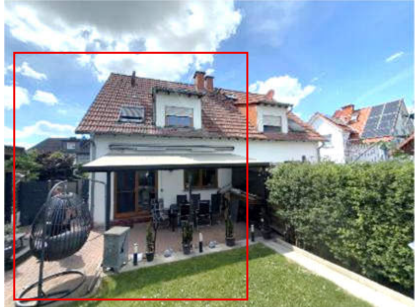
Foto 3 des SV: Bachstraße 15, Gebäuderückseite; Ansicht von Osten, vom Garten; Rotmarkierung d.d. SV
