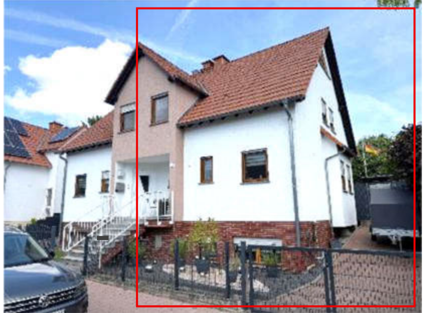
Foto 1 des SV: Bachstraße 15, Ansicht von Südwesten; Gebäudevorderseite (Eingang), Straßenansicht; Rotmarkierung d.d. SV
