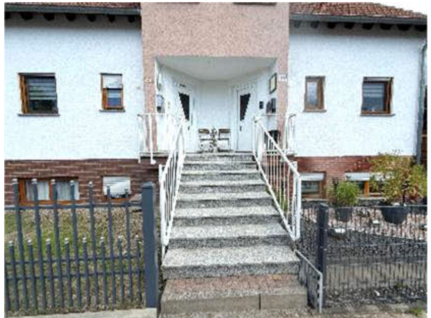
Foto 4 des SV: gemeinsamer Eingangsbereich Bachstraße 15, 15a
