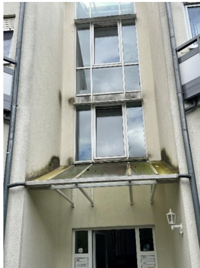
Verschmutzungen am Vordach des Eingangsbereichs / Verfärbungen an der Fassade
