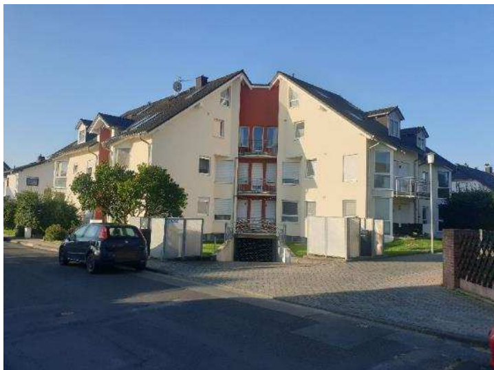
Blick auf die Nordostseite des Gebäudes
