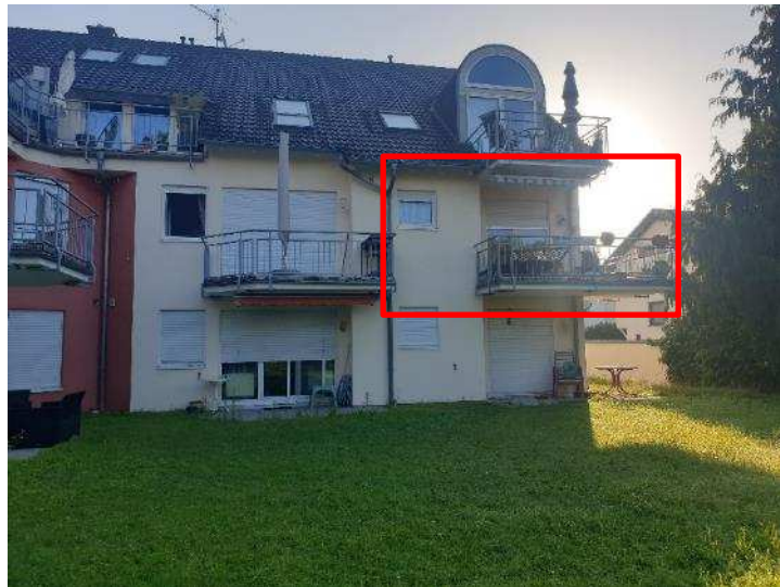
Rückansicht Gebäude (Haus Nr. 17)
