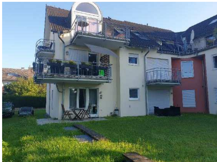
Rückansicht Gebäude (Haus Nr. 17a)
