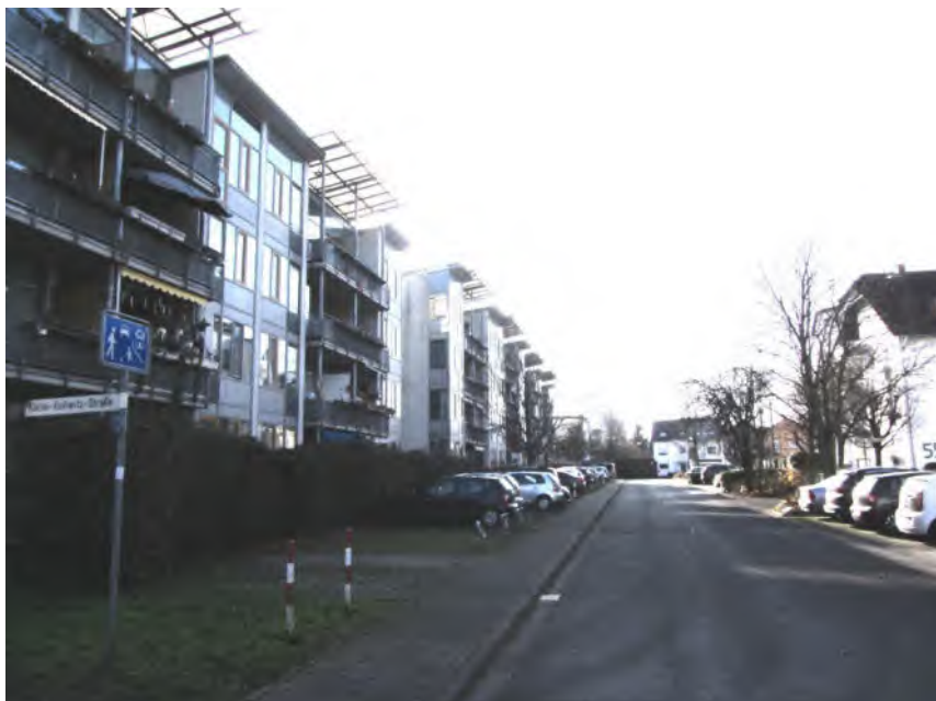
Bild 8: Nachbarbebauung im Straßenverlauf
