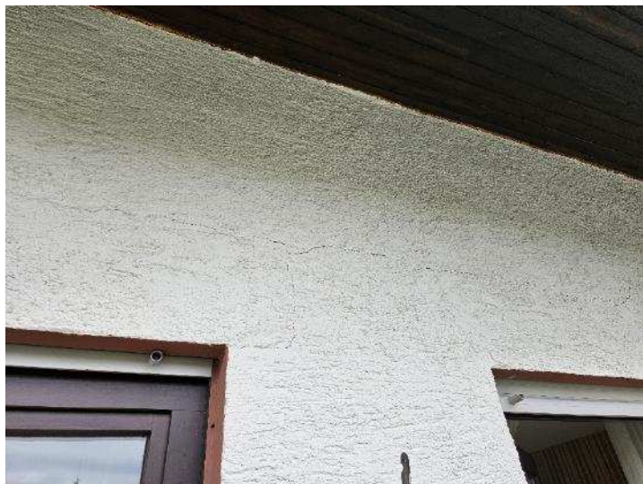
Rissbildungen im Mauerwerk an den Außenwänden - exemplarisch
