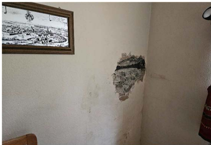
Großflächiges Loch in der Wand
