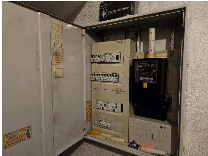
Sicherungskasten Unterputz mit Kippschaltung
