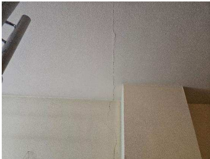
Rissbildungen an den Innenwänden - exemplarisch
