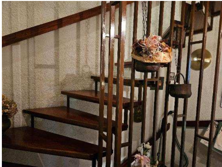
Treppenaufgang EG-OG, Stahlkonstruktion mit Holzstufen
