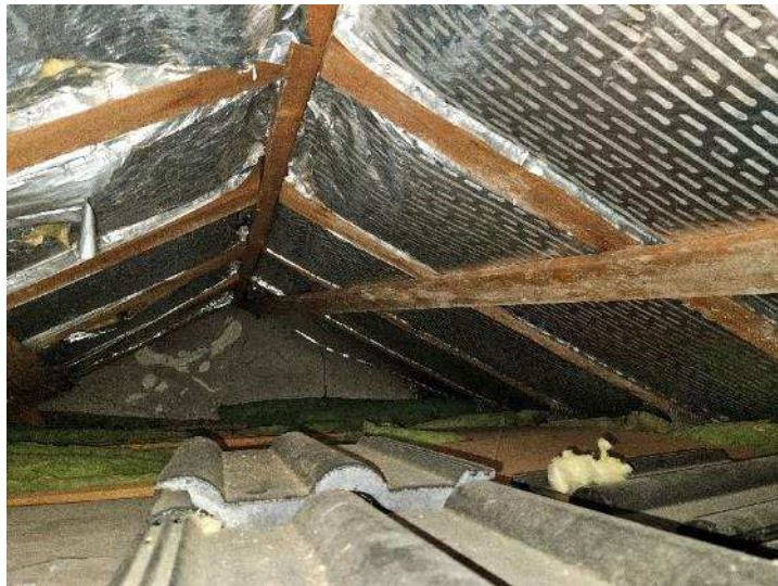
Dach - Dämmung mit Dampfsperre
