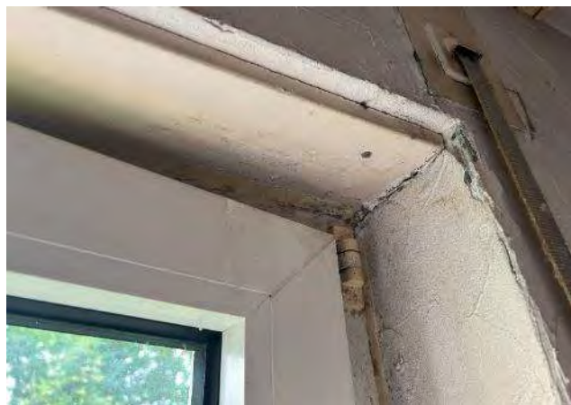
Leichte Feuchteschäden mit beginnender Schimmelbildung am Rollladenkasten im Schlafzimmer - exemplarisch
