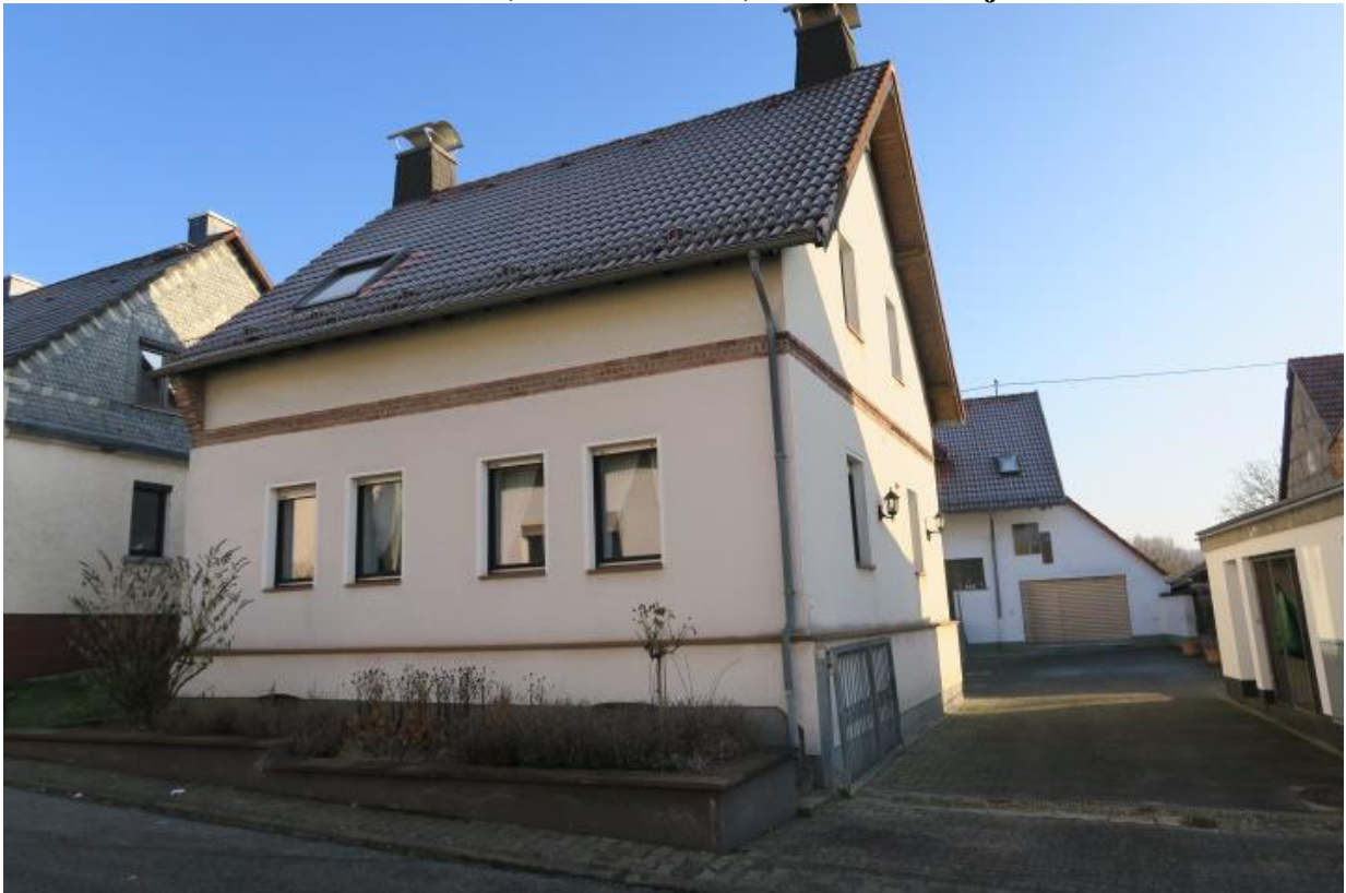
Foto1: Ansicht des Vorderhauses (Einfamilienhau) von der Niederjosbacher Straße
