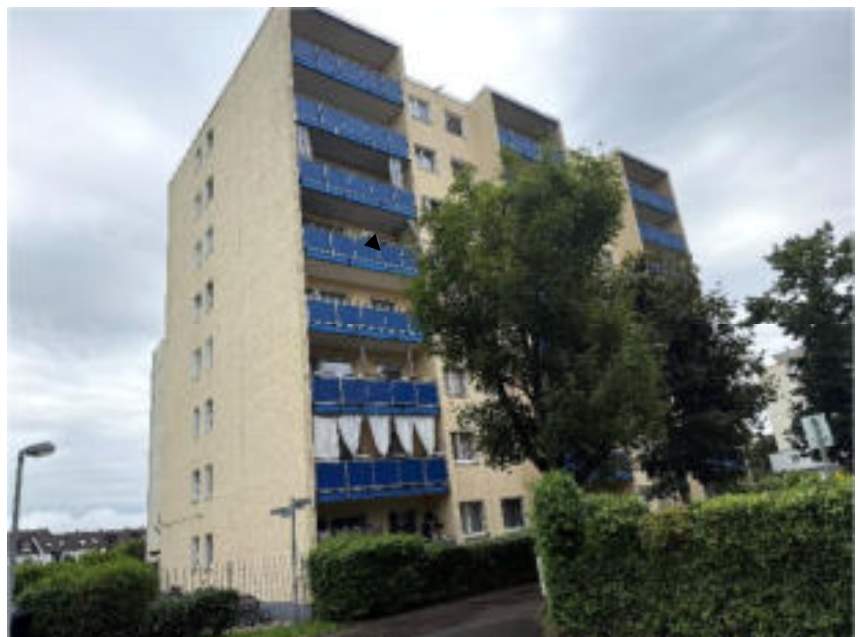
Foto 2 des SV: Dresdener Straße 1 d, Ansicht von Westen; Gebäuderückseite
