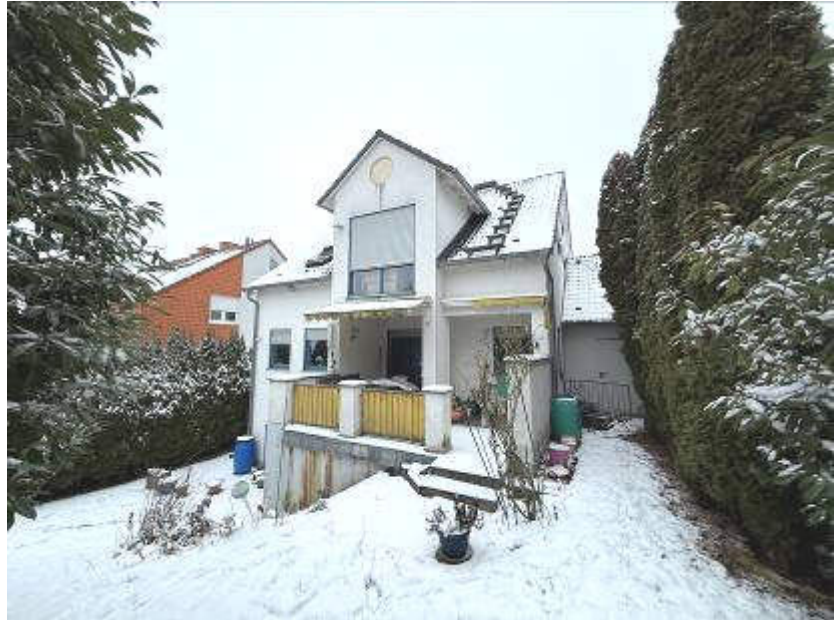
Foto 3 des SV: Ansicht von Südwesten, Gebäuderückseite
