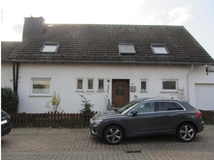
Bild 1: Längsseite des Bewertungsobjekts aus nördlicher Richtung
