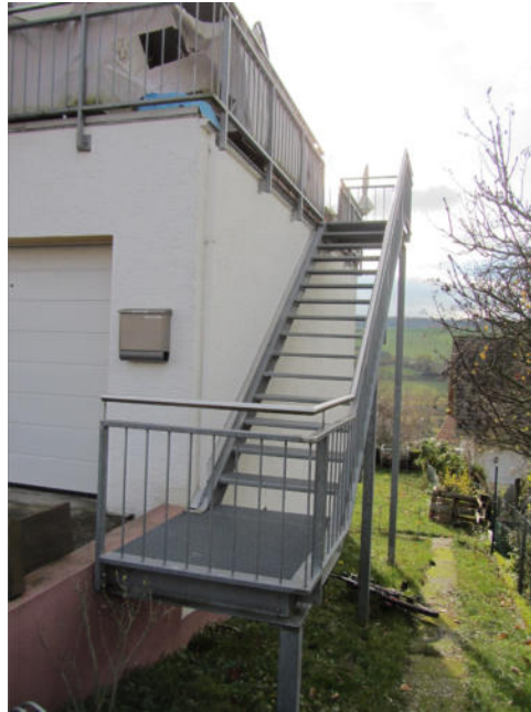
Bild 5: Treppenanlage zur Terrasse oberhalb der Garage
